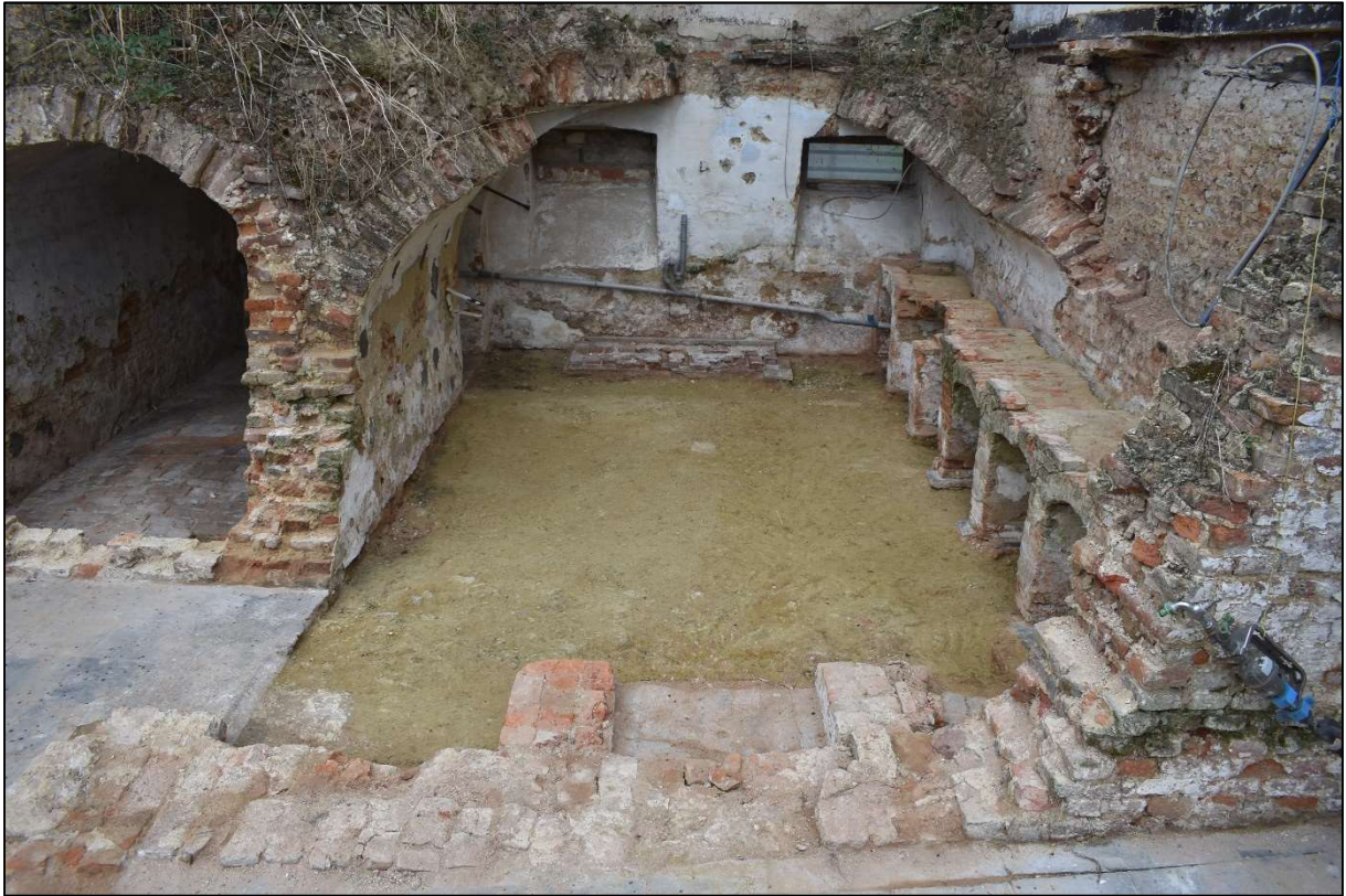
Afb. 7: Zicht op kelder 3 met wijnrek.
