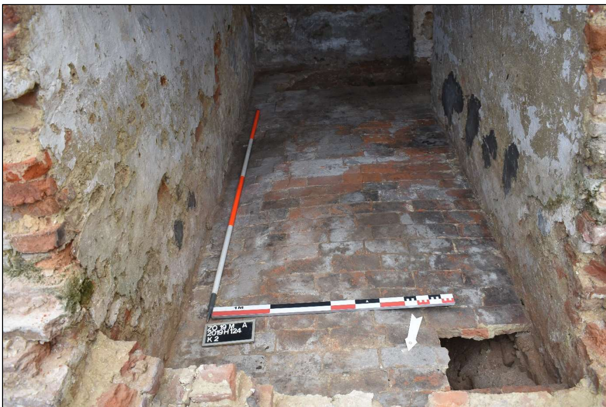
Afb. 6: Vloer van kelder 2 (gang) met recent gemaakte opening.
