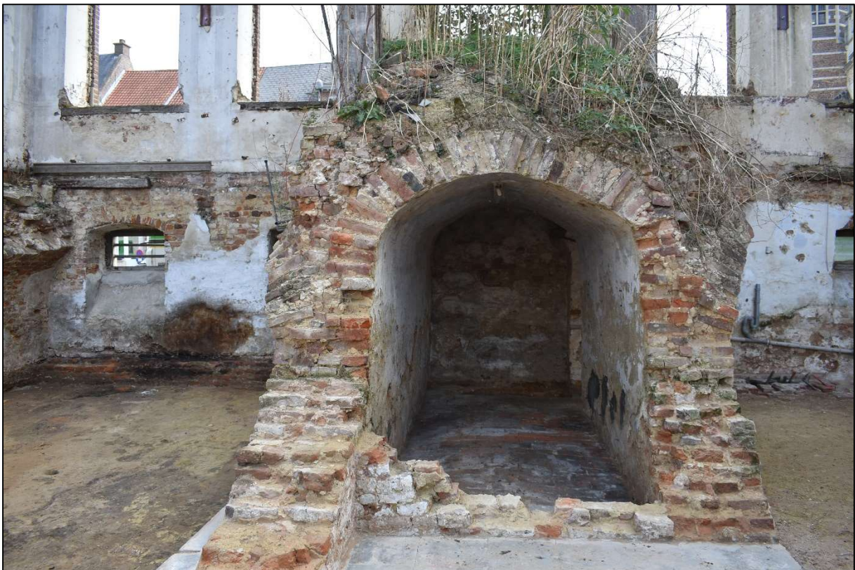
Afb. 5: Zicht op kelder 2 (gang) met intact tongewelf.
