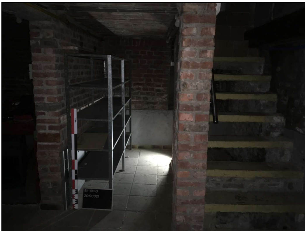
Afb. 10: foto's toegang kelderruimte met trap (Bron: Aron bv, dd 27/03/2019, 2019C321).
