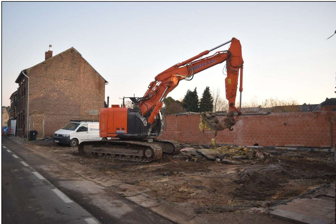
Afb. 17: foto van de sloopwerken op het terrein met links de korenwal (Bron: Aron bv, dd 04/12/2019, 2019C321).
