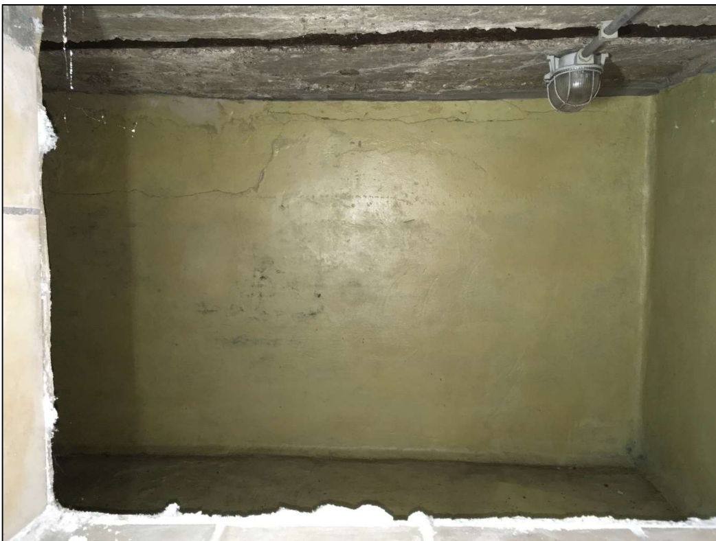
Afb. 13: foto kleinere kelderruimte (Bron: Aron bv, dd 27/03/2019, 2019C321).
