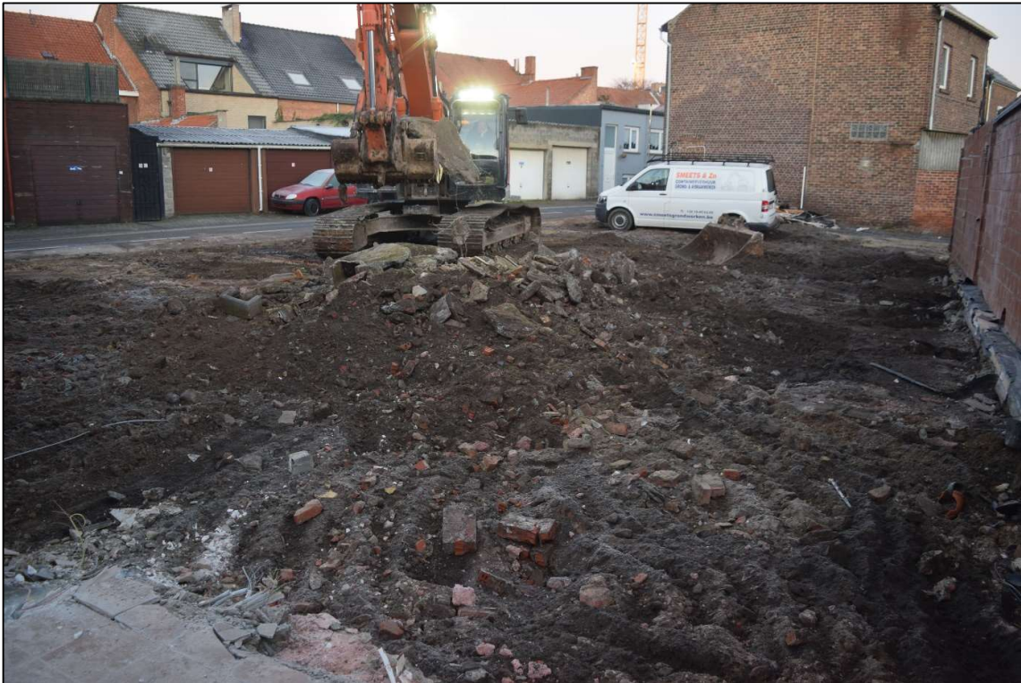
Afb. 18: Zicht op de sloopwerken in het noordelijk deel van het terrein (Bron: Aron bv, dd 04/12/2019, 2019C321).
