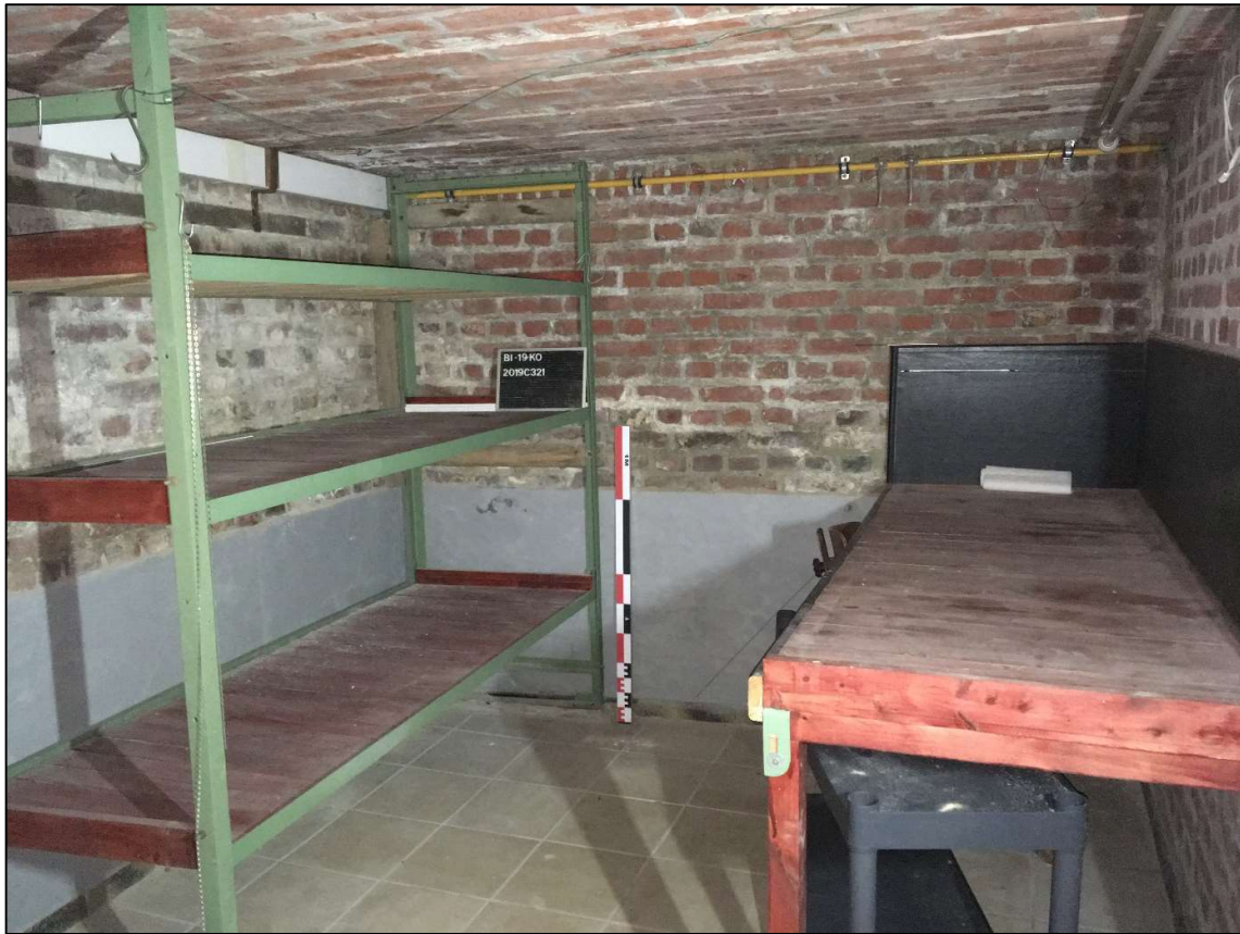
Afb. 16: foto zuidoostelijke kelderruimte (Bron: Aron bv, dd 27/03/2019, 2019C321).
