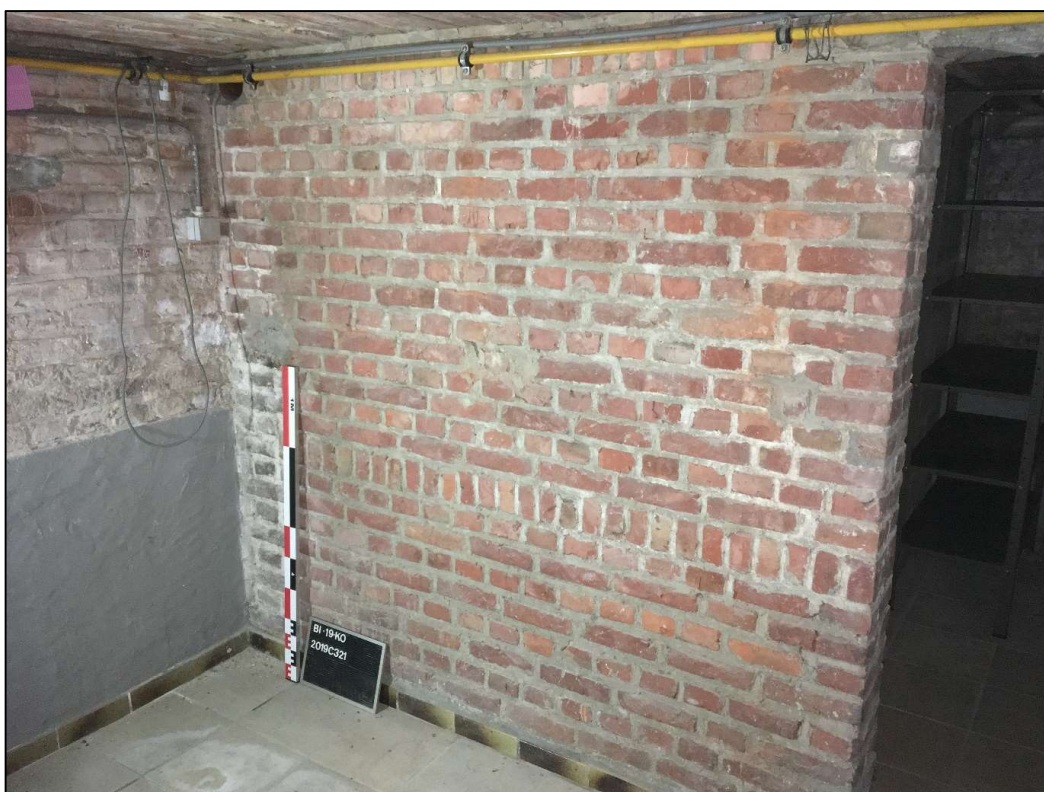
Afb. 11: foto's toegangsruimte kelder (Bron: Aron bv, dd 27/03/2019, 2019C321).
