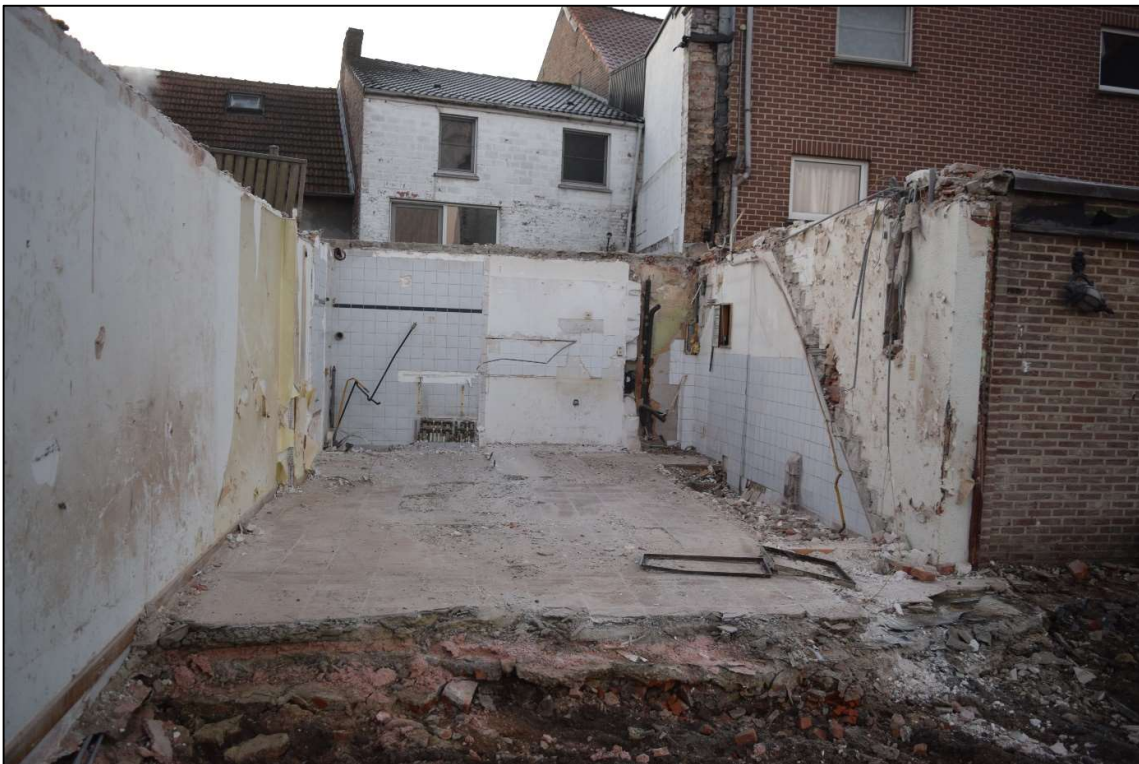
Afb. 21: Zicht op de vloerplaat op het uiterst zuidelijk deel van het onderzoeksgebied. Onder deze vloerplaat lag de geregistreerde kelder die niet gesloopt, maar gedempt werd. De toegang naar de kelder is rechts op de foto nog zichtbaar (Bron: Aron bv, dd 04/12/2019, 2019C321).
