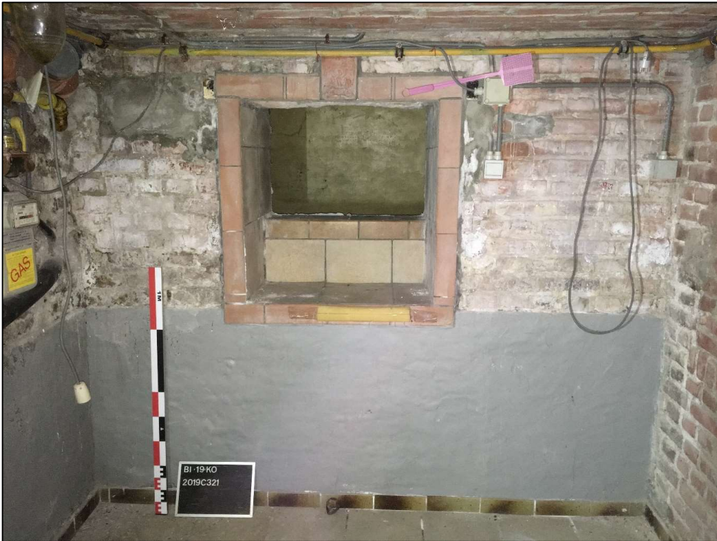
Afb. 12: foto toegangsruimte kelder met betegelde doorgang naar kleinere ruimte (Bron: Aron bv, dd 27/03/2019, 2019C321).
