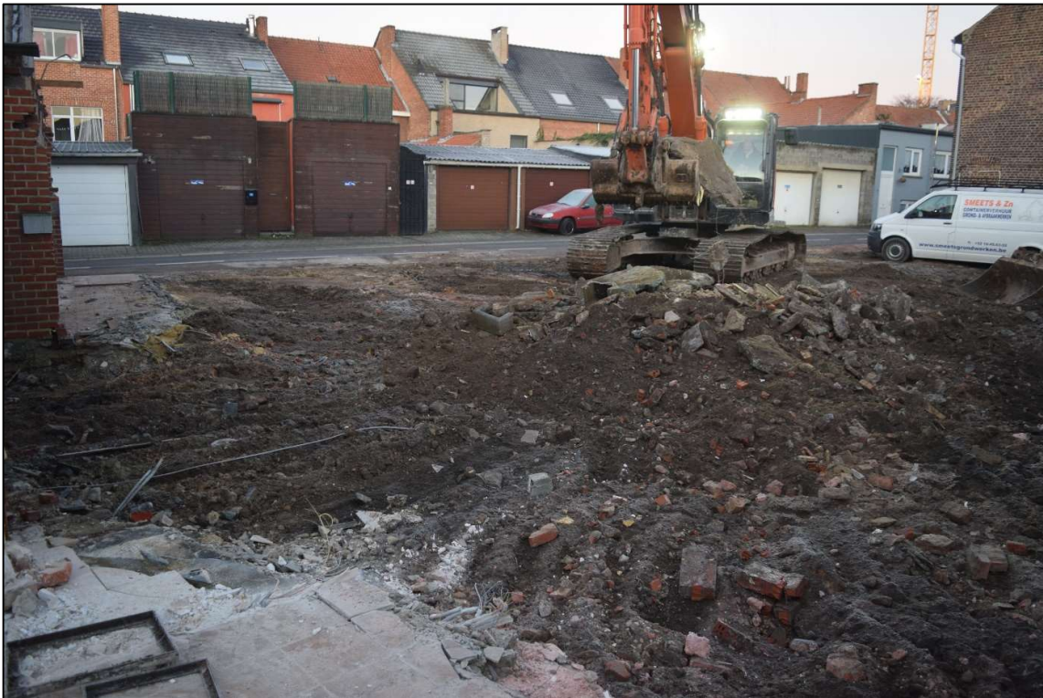
Afb. 19: Zicht op de sloopwerken centraal op het terrein met het sloopaafval dat rechtstreeks gebruikt werd om het terrein op te hogen (Bron: Aron bv, dd 04/12/2019, 2019C321).
