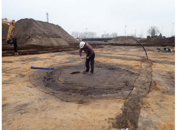
Figuur 12: Sebastiaan boort een waterput voor er bemaling geplaatst wordt
