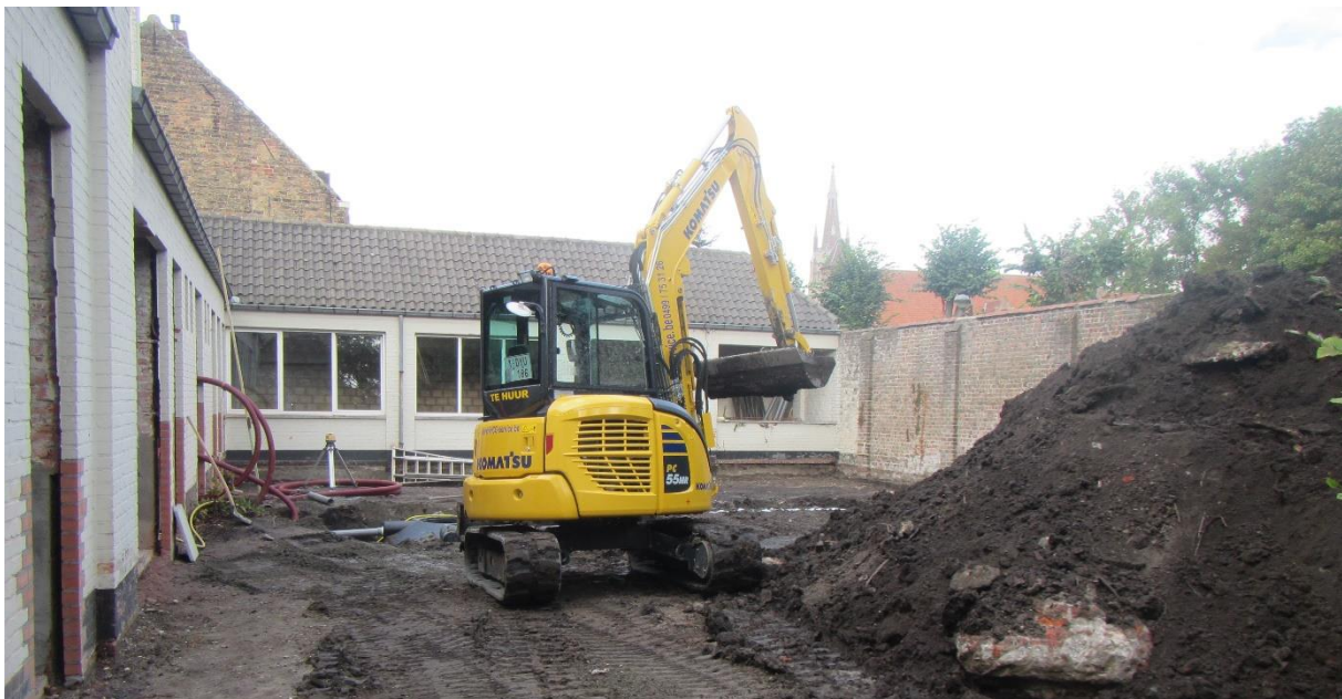
Figuur 21: Terreinopname van het veldwerk
