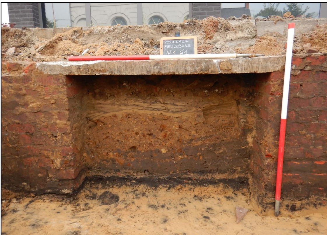
Figuur 44 Zicht op de zuidelijke muur van de structuur met uitsparing/luchtgat en betonnen linteeel. Merk duidelijk de gelaagde lensvormige opvulling op.
