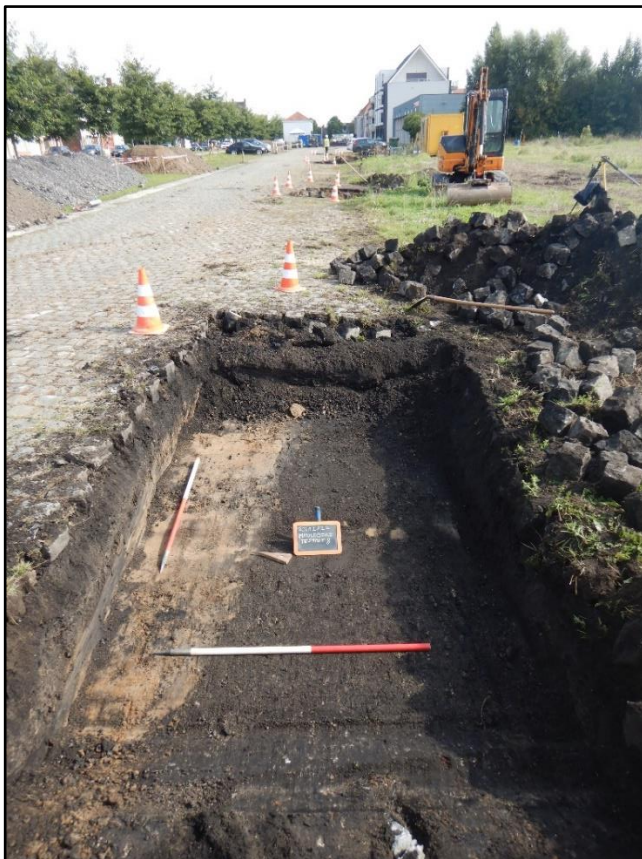
Figuur 10 Zicht op de opeenvolgende testputten met op de voorgrond testput 8 (foto genomen richting oosten met op de achtergrond het witte stationnetje).
