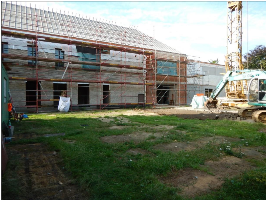
figuur 4 Overzicht van het terrein voor de aanvang van de werken, genomen vanuit de noordoosthoek. Links bevinden zich werfketen, rechts een torenkraan. Op die manier werd het te onderzoeken oppervlak beperkt tot de beschikbare ruimte.
