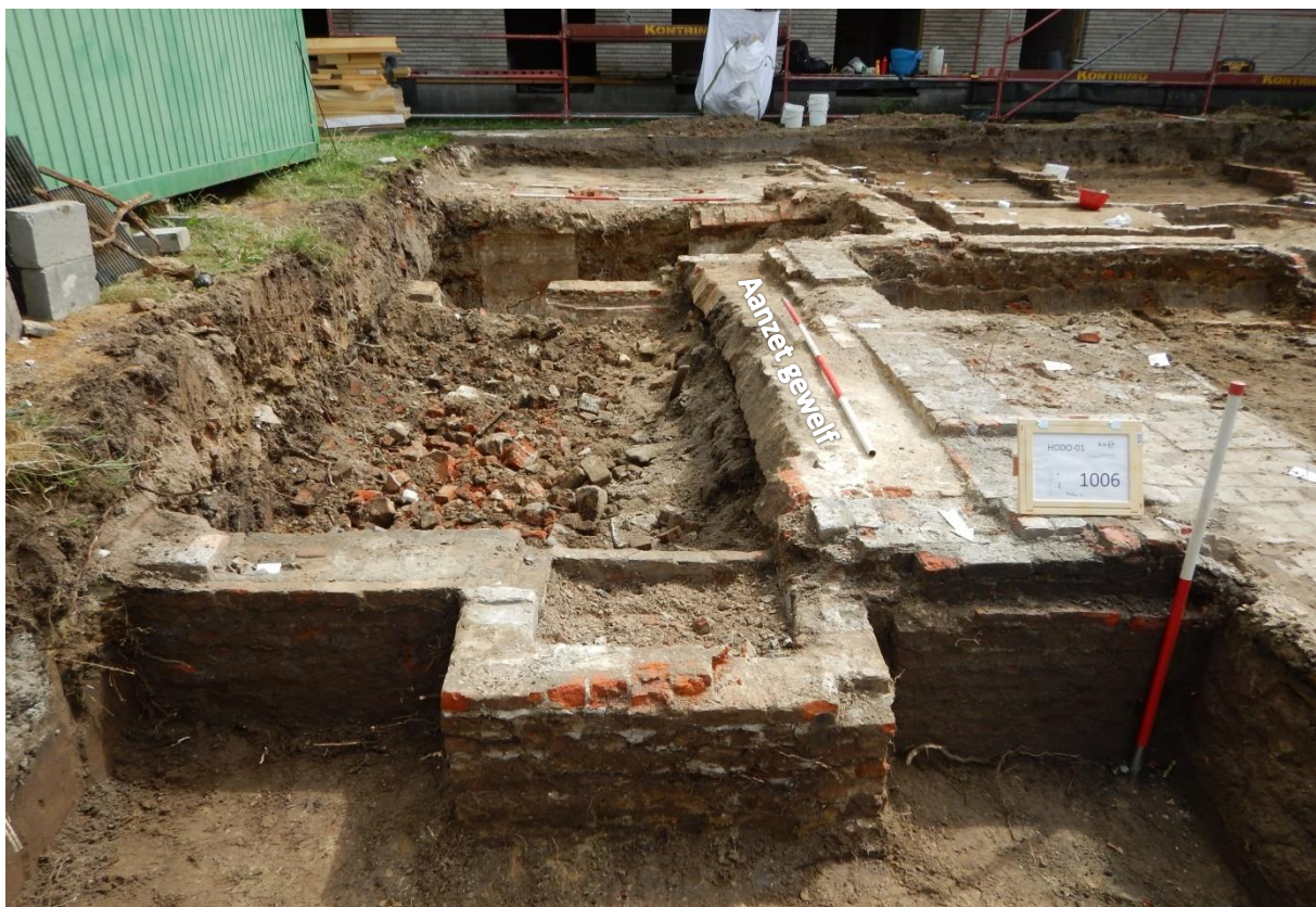
figuur 31: Zicht op de noordelijke kelder met keldergat. Rechts is de aanzet van het gewelf bewaard. Achter de kelder is de tweede kelder zichtbaar.
