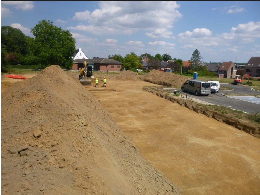
Figuur 5: zicht op werkput 2
