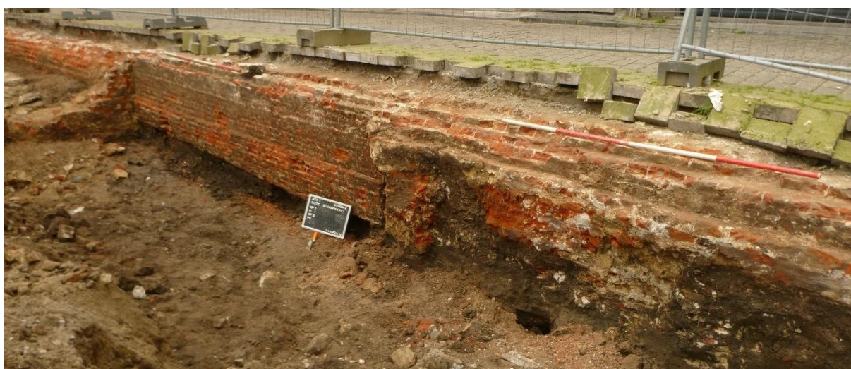
Figuur 163: Fundering voorgevel S1008 en S1009.
