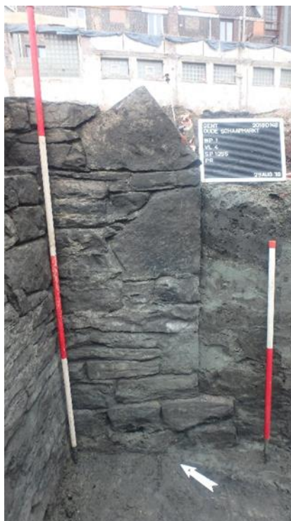
Figuur 38: Eén van de steunberen van S1045 in profiel B.
