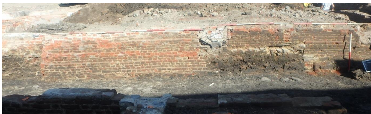
Figuur 165: Fundering van de zijgevel S1021.
