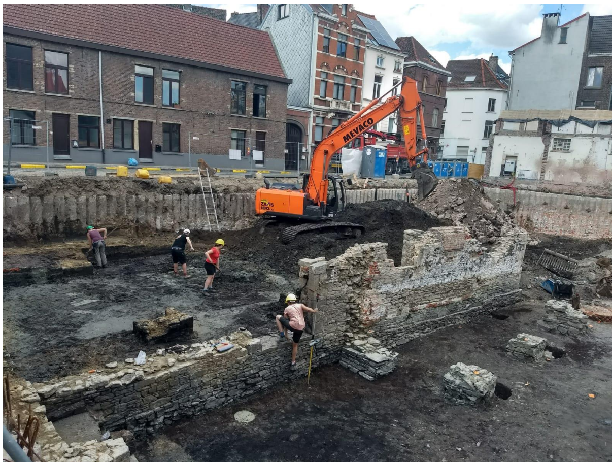
Figuur 49: Sfeerbeeld tijdens de opgraving met zicht op de oostelijke gevel van het Steen ST229. Een collega 'betreedt' het pand via de deuropening.
