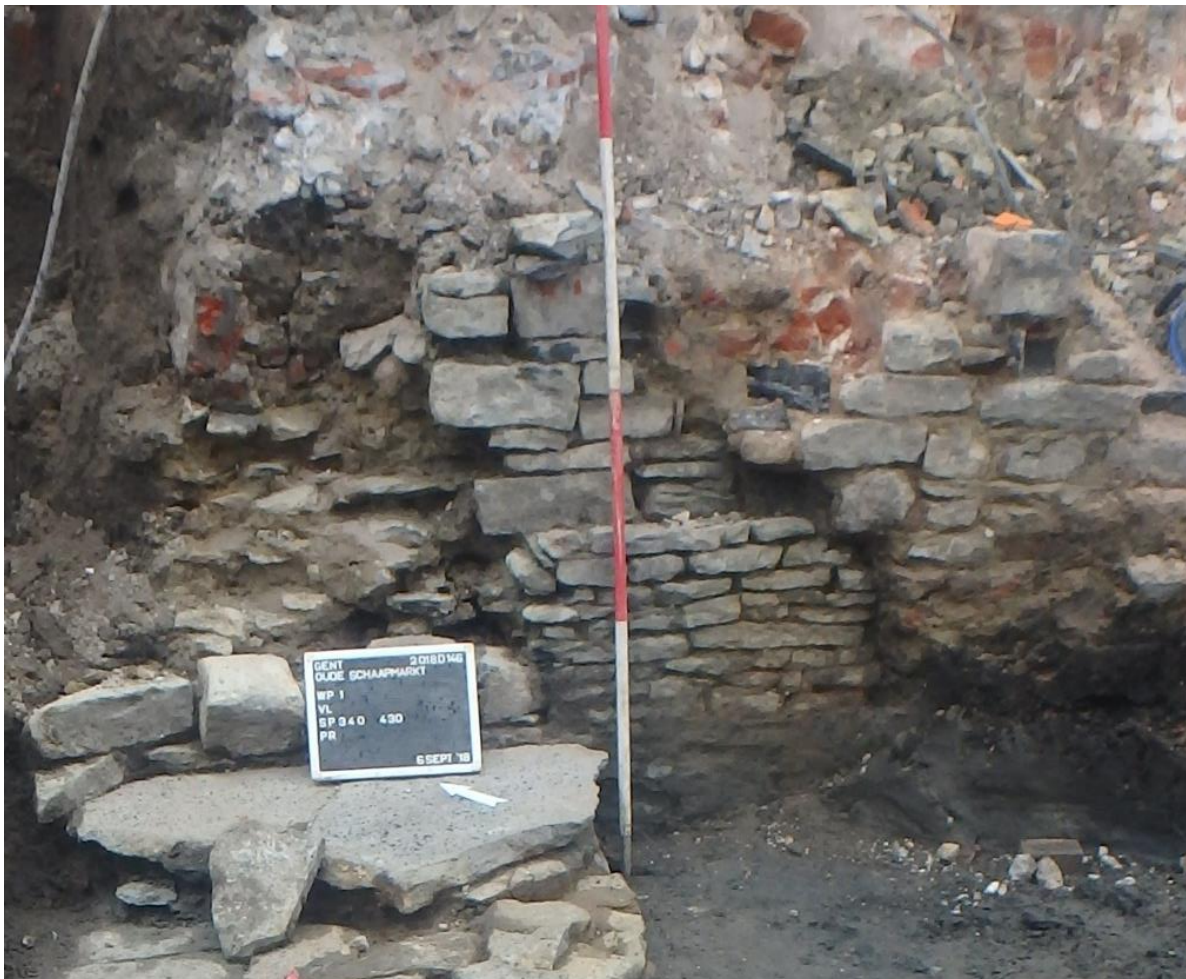
Figuur 18: Restant van de slecht bewaarde kademuur S1422 in de noordwestelijke hoek van het onderzoeksterrein.
