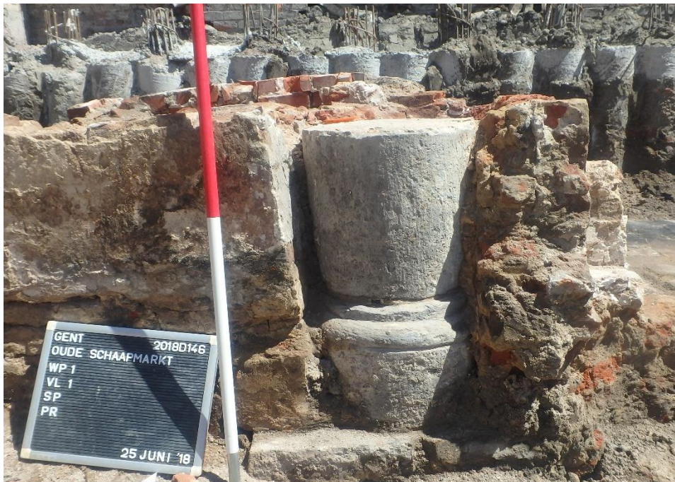
Figuur 133: Natuurstenen zuil S1085 ingeklemd tussen recenter muurwerk.
