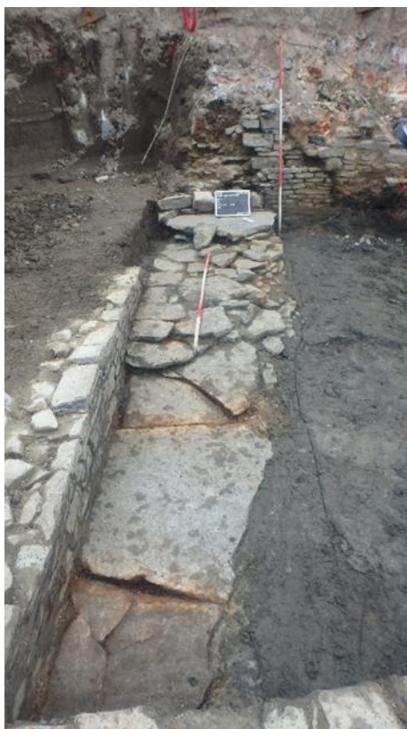
Figuur 83: Detail van de natuurstenen afdekplaten van de goot S1430. Achterin de aansluiting met de natuurstenen kademuur S1422
