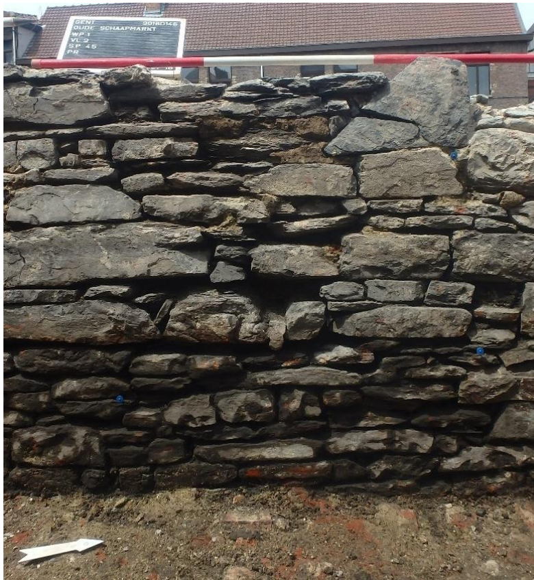
Figuur 24: Detail van het metselwerk van de tuinmuur S1045.
