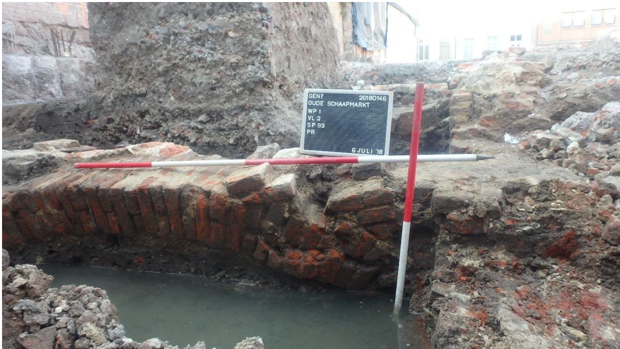
Figuur 140: Verzakte achtergevel op spaarboog van de 14 de eeuwse uitbouw.
