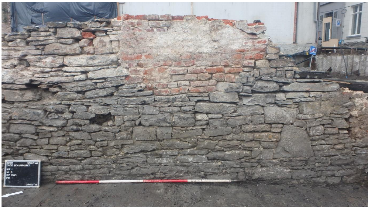
Figuur 25: Deel van de omheiningsmuur, S1045, met jongere baksteen-opvulling.
