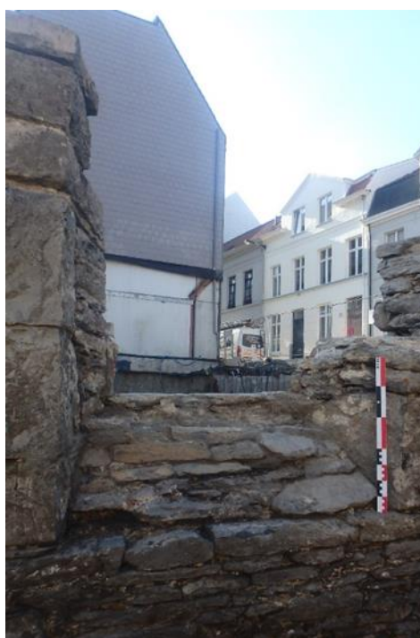
Figuur 62: Raamopening C van binnenuit gezien, met afgeschuinde kanten.
