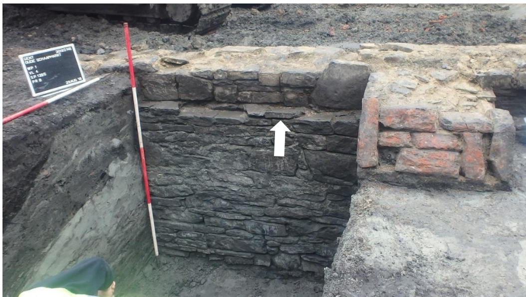
Figuur 35: Fundering van S1045 met aanduiding van de uitkraging (pijl) en rechts één van de steunberen met afzaat (afgeschuinde zijde).
