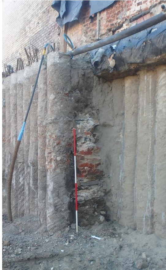
Figuur 124: Eén van de poeren van ST230 ingeklemd in de secans-palenwand.
