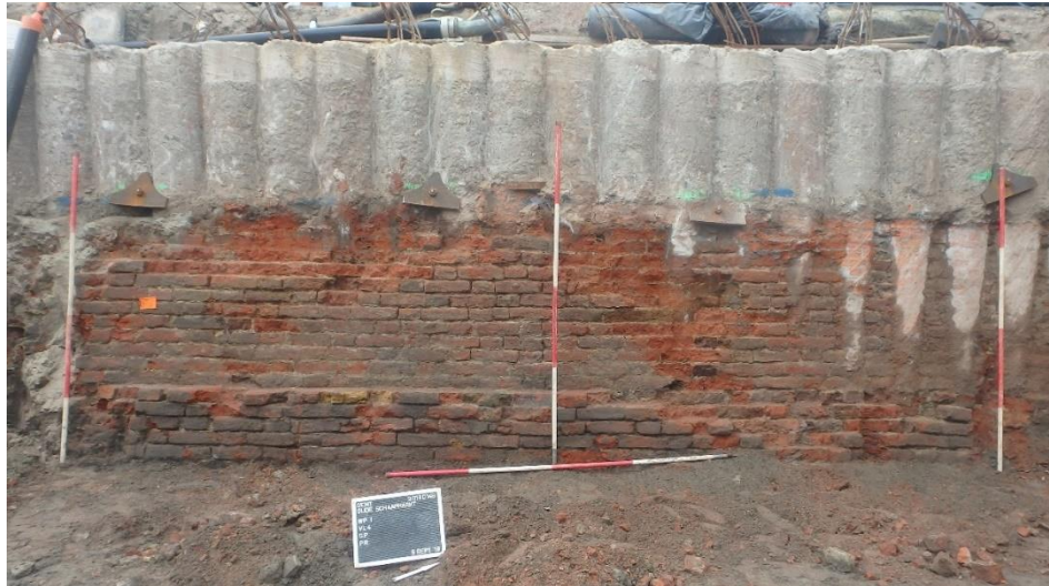
Figuur 118: Tuinhuismuur S1421 tegen de palenwand.
