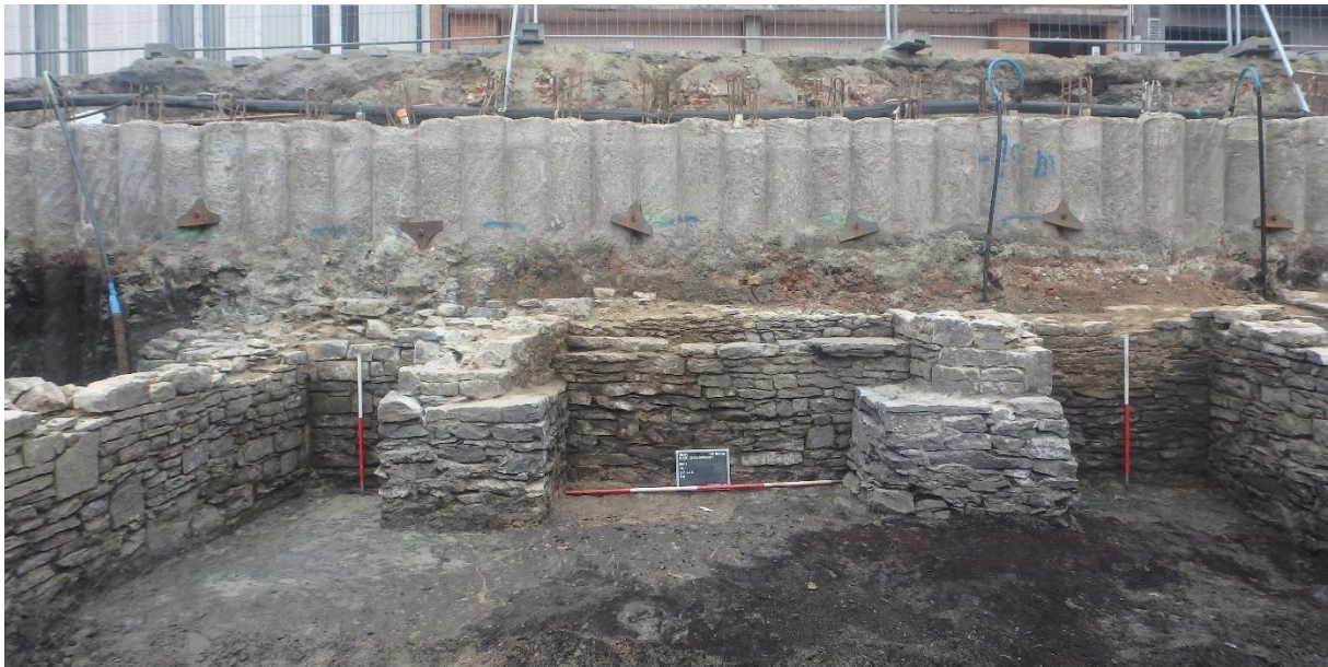
Figuur 47: Zicht op de fundering van de poort, na verwijderen S1439. Foto richting zuidwesten.
