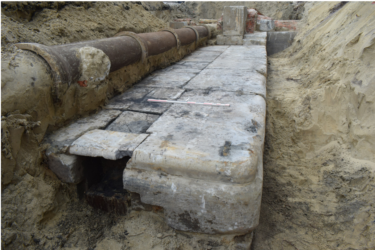
Figuur 14: Overzicht vanuit het zuiden, onderaan in beeld de uitsparing voor schutbalken in de zuidrand van het platform met houten plankjes en erlangs ondiepe vertrappingen (© Stad Antwerpen dienst archeologie).
