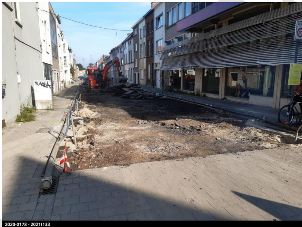
Figuur 2: Werkzone na verwijderen bestrating. Foto richting noorden.
