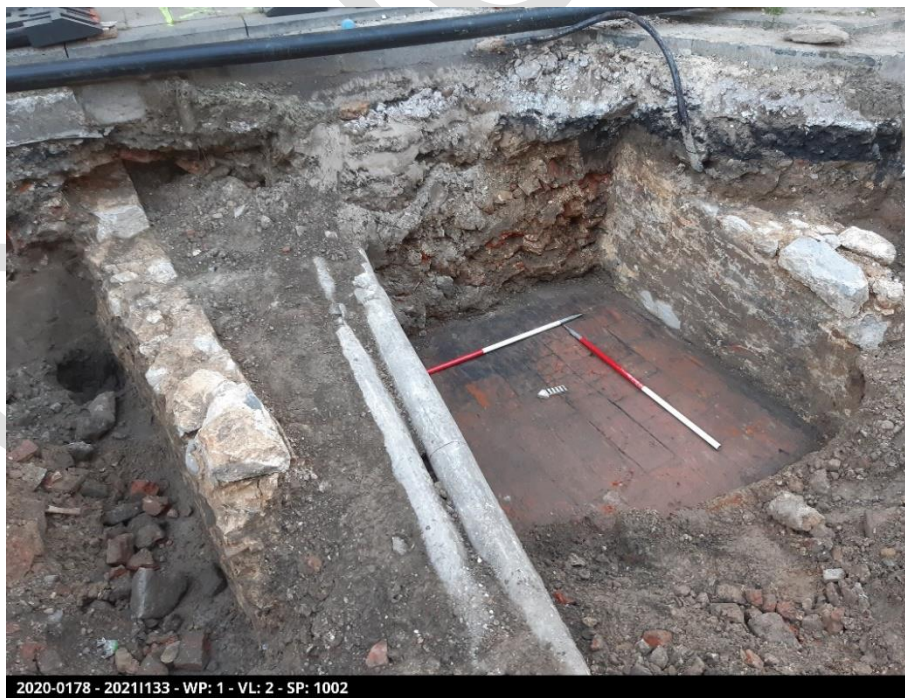
Figuur 8: Keldertje S1002/1004. Doorheen de kelder lopen twee asbestbuizen die door de archeologen niet werden verwijderd.
