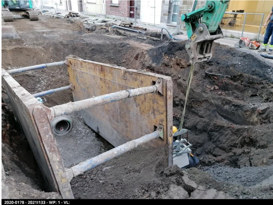
Figuur 9: Het leggen van de nieuwe rioleringsbuizen.
