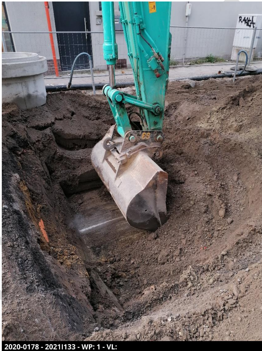
Figuur 3: Aanleg van de werkput. De graafbak schraapt hier net over de bestaande rioolbuis.
