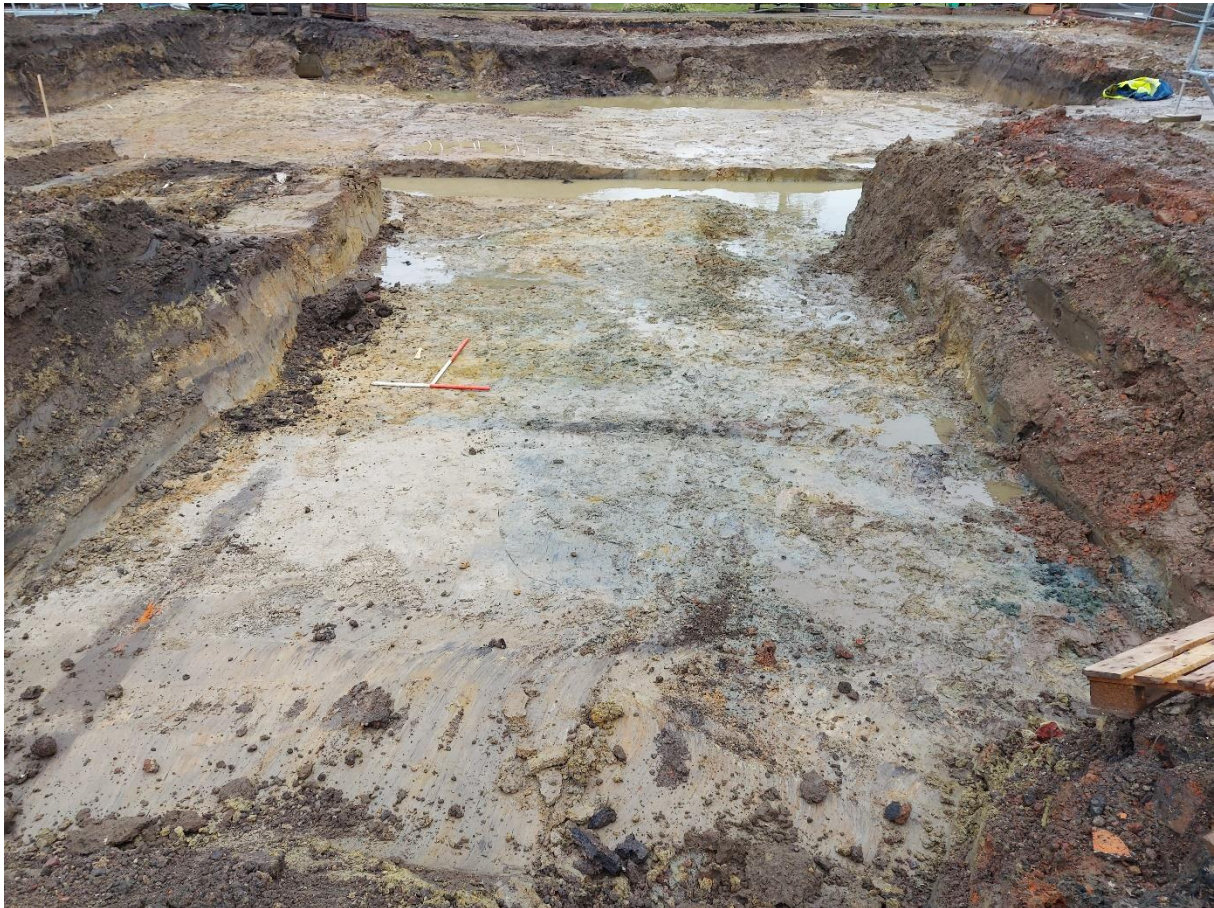
Figuur 10: Vervuiling door benzine ter hoogte van het archeologische vlak.
