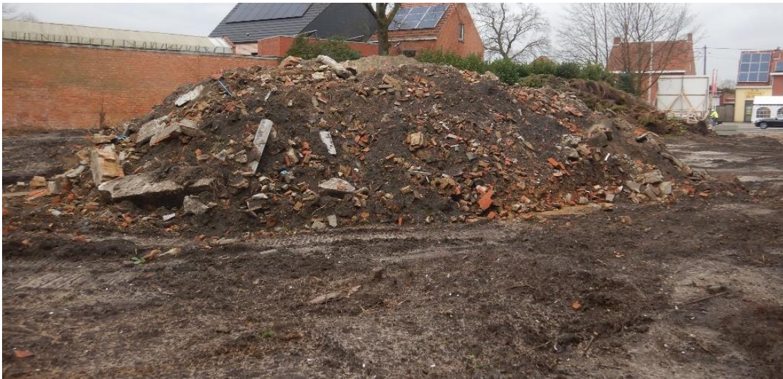
Figuur 11: Werkfoto van de reeds afgebroken onderkelderde woning
