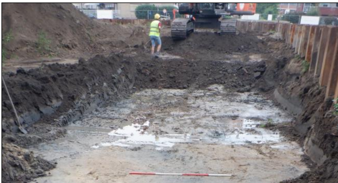
Figuur 3: Aanleg vlak 1 in werkput 1 buiten de beschoeiing en nabij de Leiemeander.
