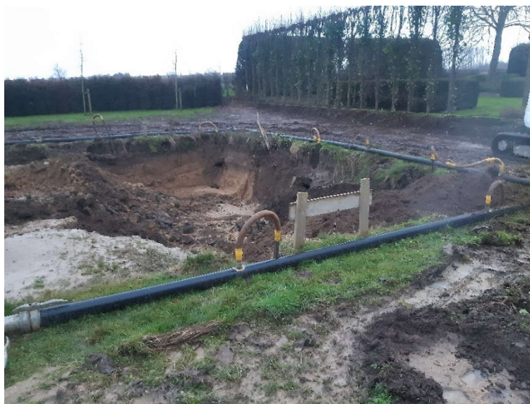
Figuur 16: In het zuiden van werkput 2 was reeds een diepe uitgraving aanwezig
