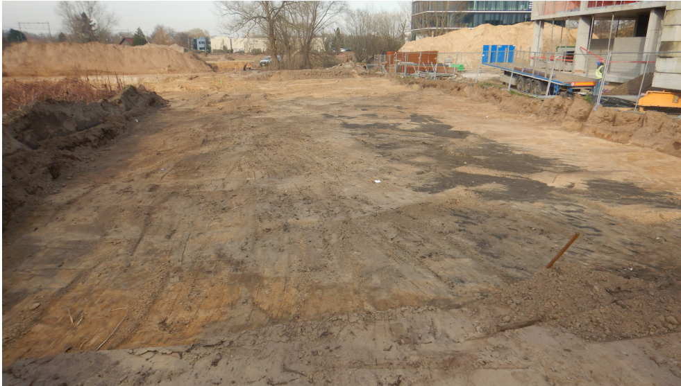
Figuur 7. Werfcontrole in de zuidoostelijke hoek van het onderzoeksgebied na het afgraven van de grondstock (foto genomen in noordwestelijke richting).
