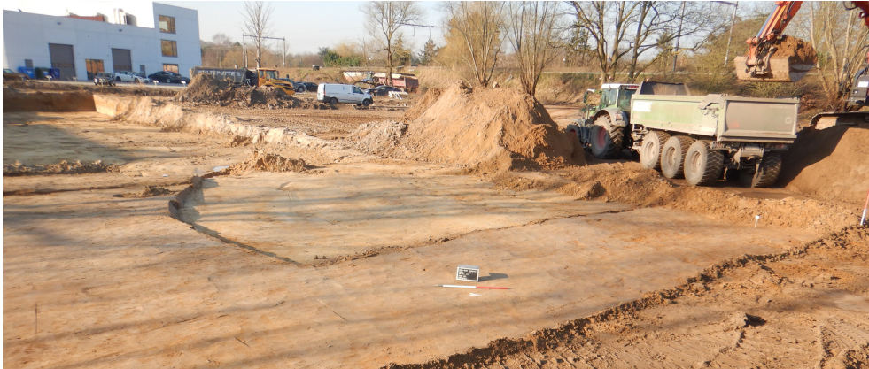
Figuur 11. Het eerste deel van de aanleg van vlak 2.
