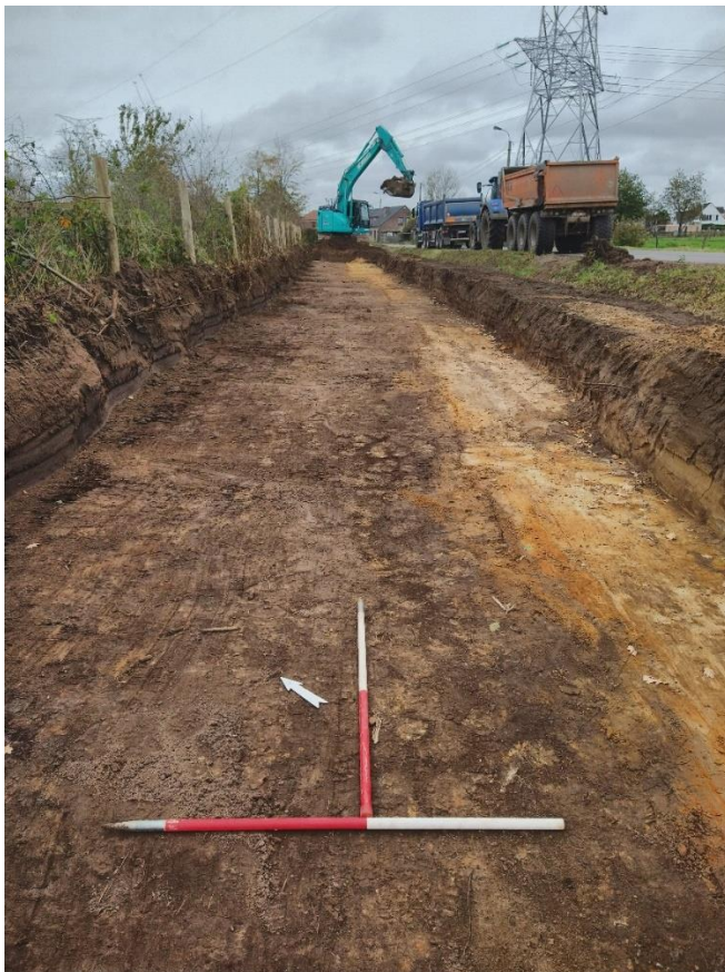
Figuur 31: Overzichtsfoto ter hoogte van werkput 1.8. (©RAAP)
