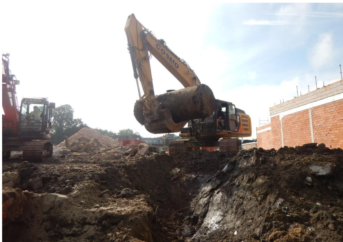
Figuur 7: Wegnemen mazouttank.
