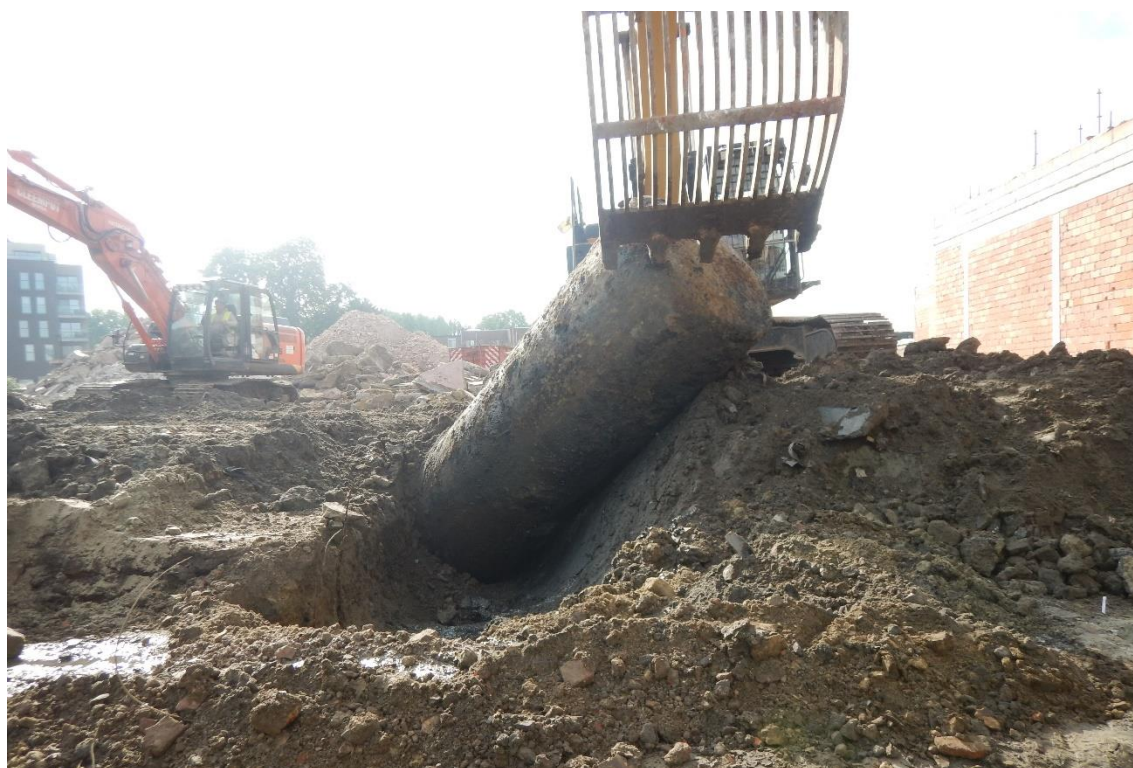
Figuur 6: Wegnemen mazouttank.
