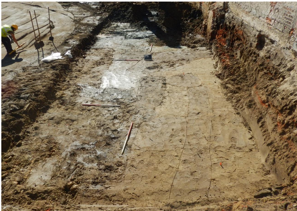
Figuur 11: Aanleg westrand na opvulling WP1 en wegbreken muur 21.
