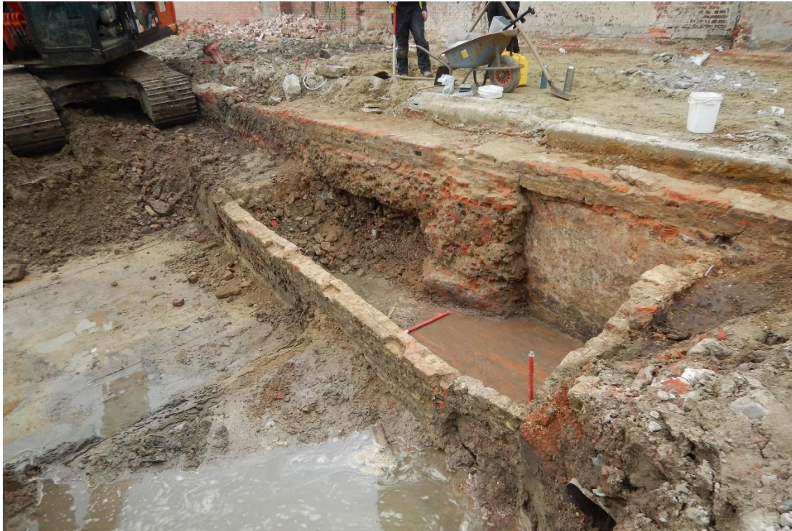
Figuur 10: Aanleg WP1 tot aan muur 21, ca.3m van de perceelsgrens.
