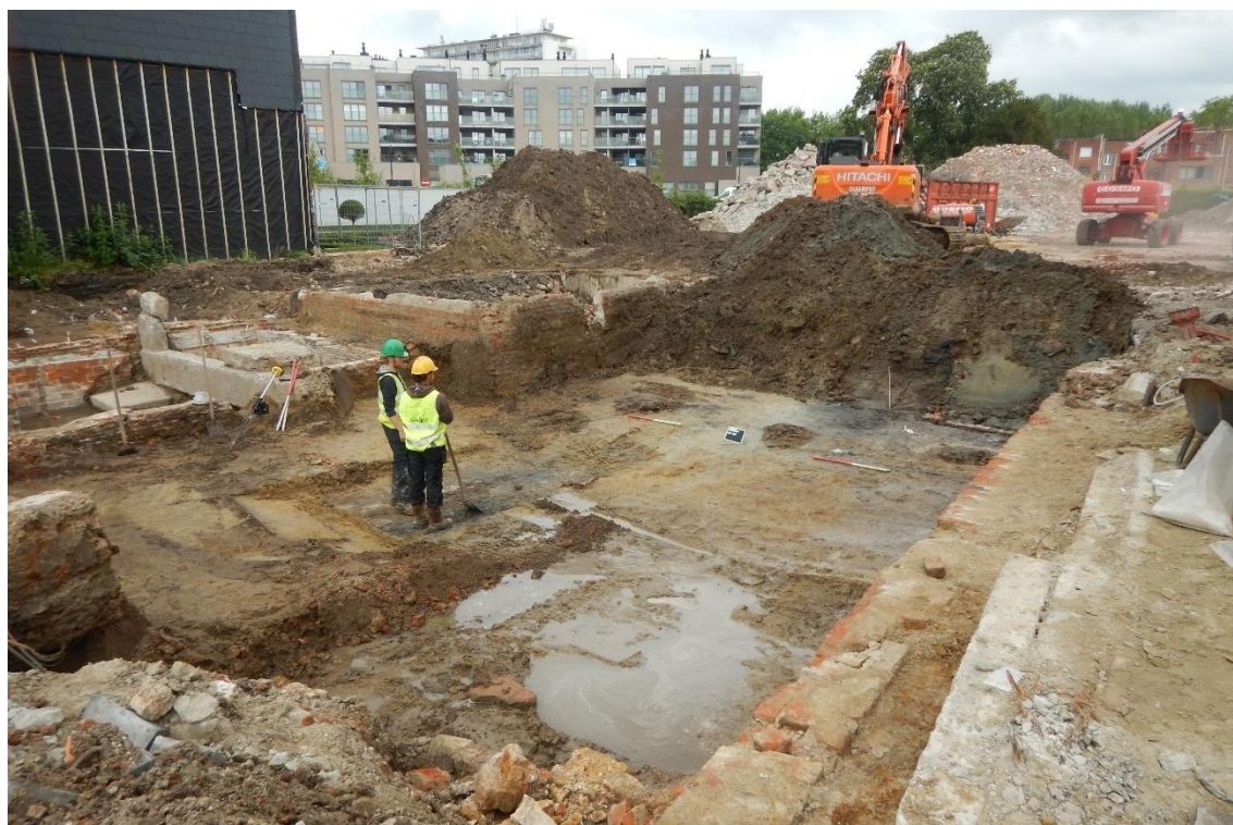
Figuur 115: Overzicht WP na aanleg vlak 2.
