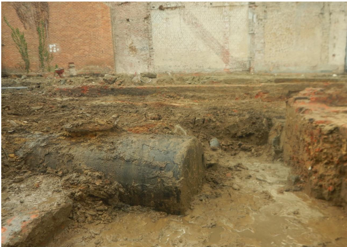
Figuur 4: Mazouttank 1, centraal in noordwesten.
