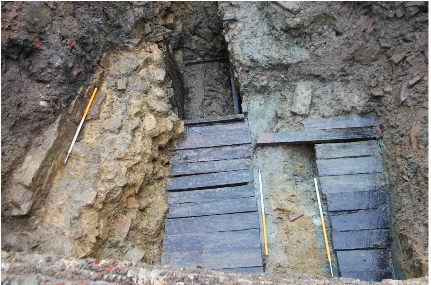
Figuur 23. Bovenaanzicht van de dakconstructie van de galerij (rechts) en de uitgang (links).
