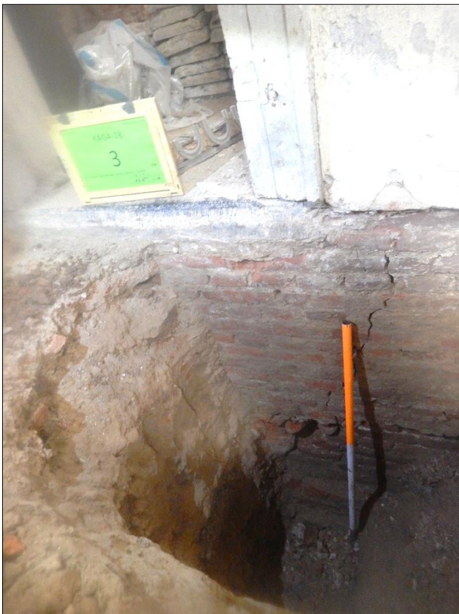
Figuur 31. Fundering van de noordmuur van de hoofdvleugel
