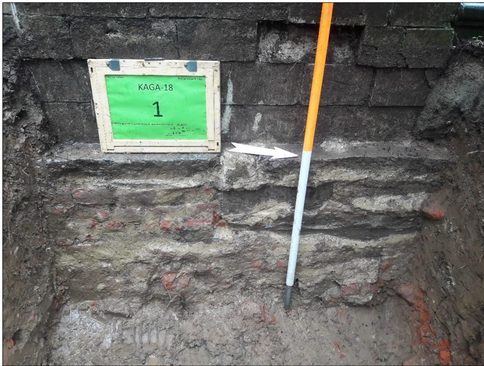
Figuur 25. WP2, detailfoto van de fundering van de noordelijke traptoren-niveau 1 (O)
