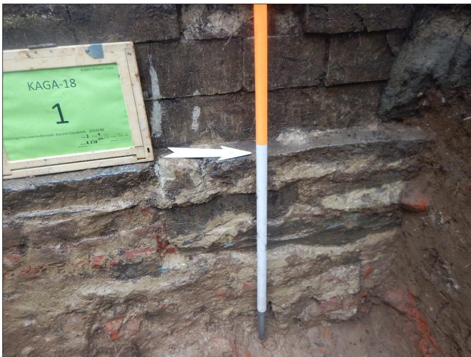
Figuur 26. WP2, detailfoto van de fundering van de noordelijke traptoren-niveau 1 (W)
