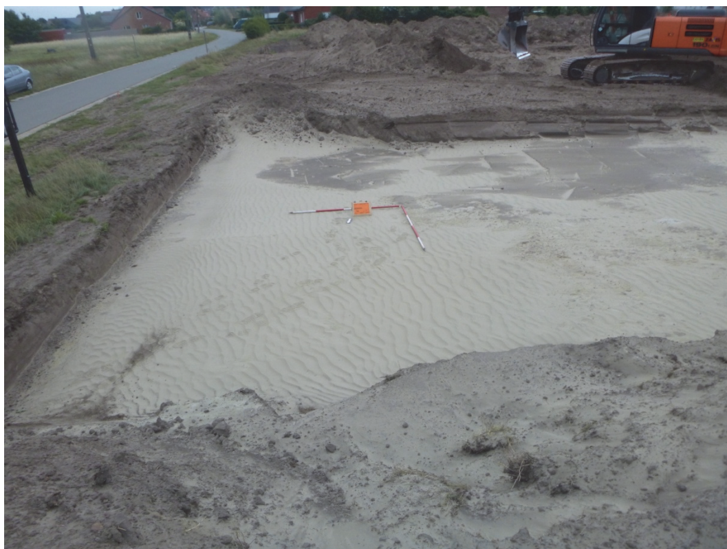
Afb. 4.4. Stuiwzand in pas aangelegde werkput.
