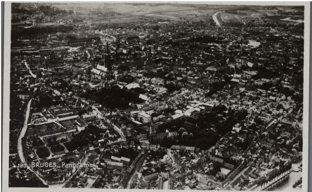
Figuur 16: Panoramisch zicht op Brugge in 1935, in de linkerbovenhoek zijn het station en de spoorwegen ter hoogte van het projectgebied zichtbaar (Stadsarchief Brugge, FO/A1509)
