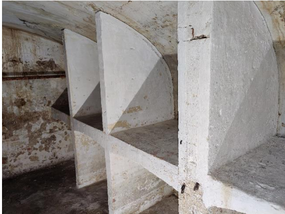
Figuur 33: zicht op opslag van muur d
