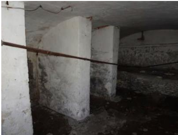
Figuur 37: Zicht op muren b en c
