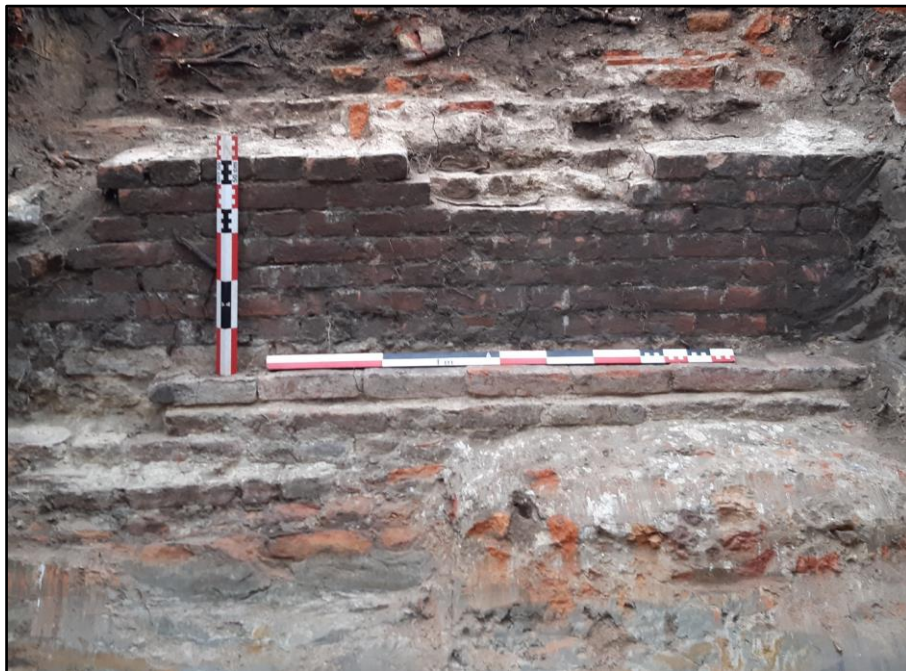
Figuur 69: Fundering met versnijdingen en opgaand muurwerk van de oostelijke muur (ABO nv 2020)
