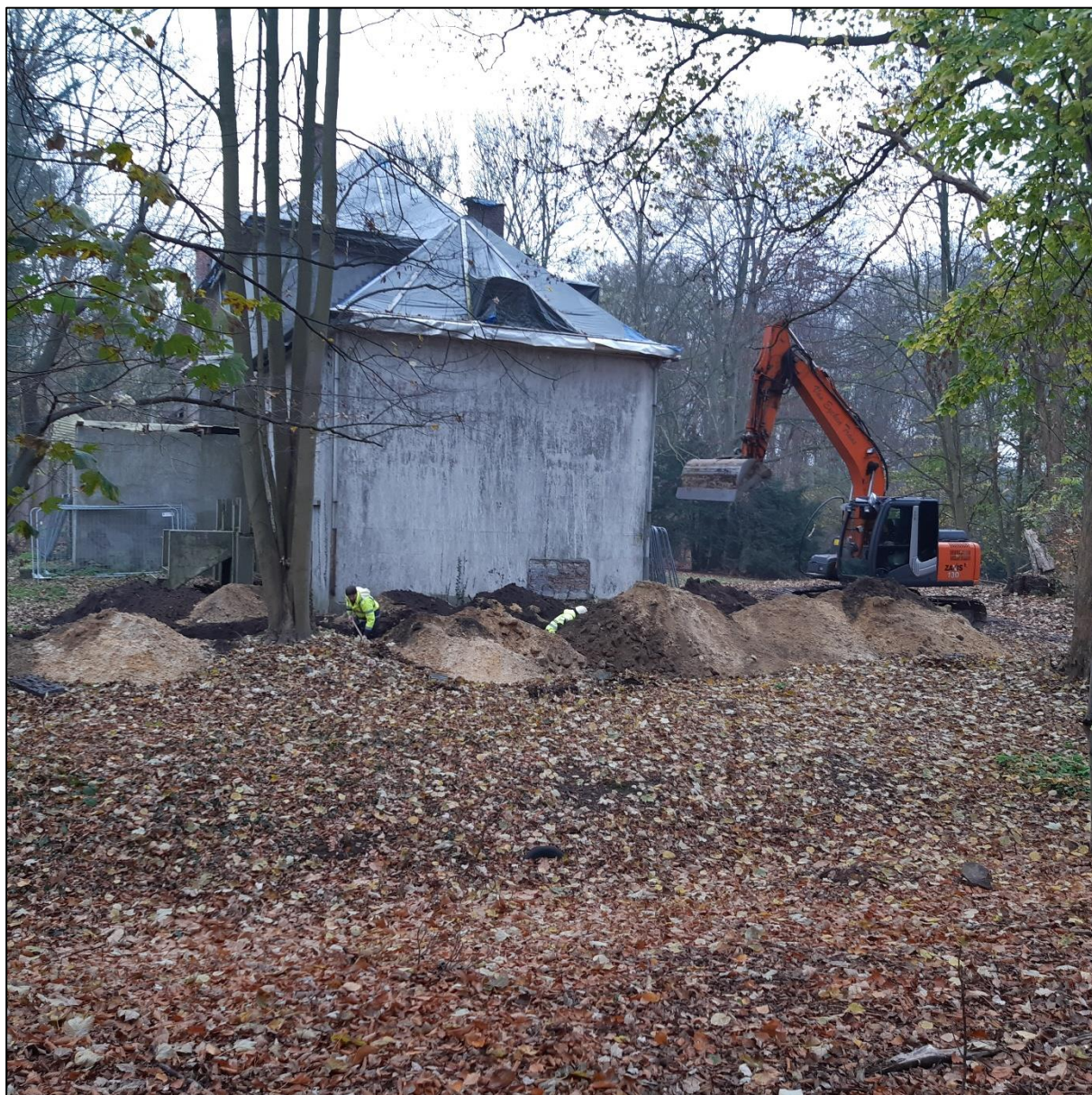
Figuur 42: Uitvoering aanleg werkput 2 (ABO nv 2020)
