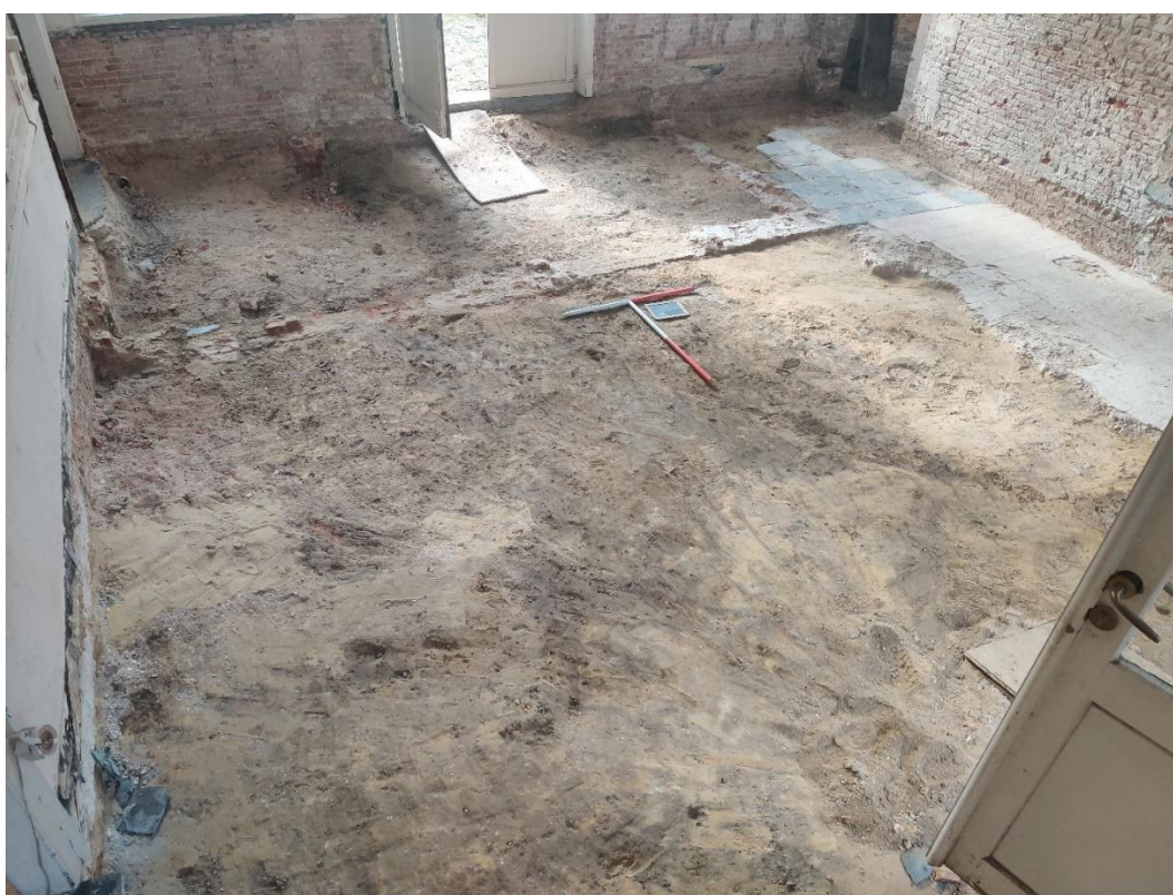
Figuur 36: Zicht op werkput 1 vlak 2.
