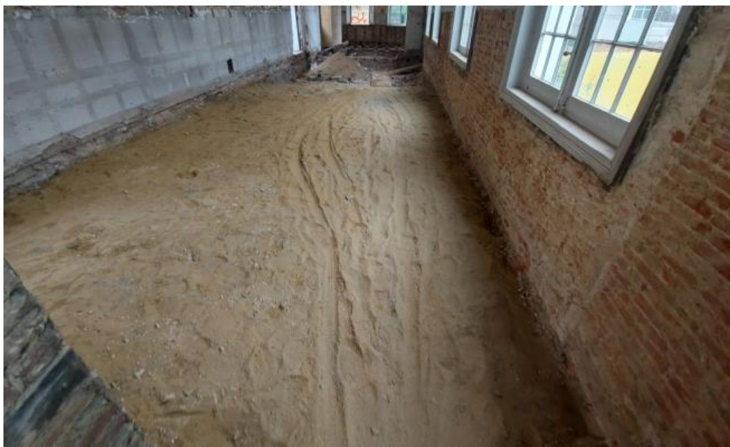
Figuur 82: Zicht op het zandbed in werkput 12 na het verwijderen van de bestaande vloer.
