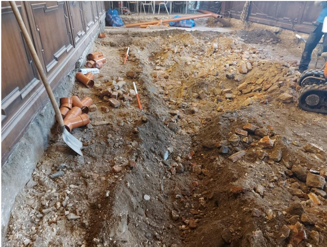
Figuur 41: Zicht op het lokaal verdiepen van werkput 2 vlak 2 naar 3 voor de aanleg van de rioleringsseuf. Hierbij werd slechts een los recent puinig pakket vastgesteld.
