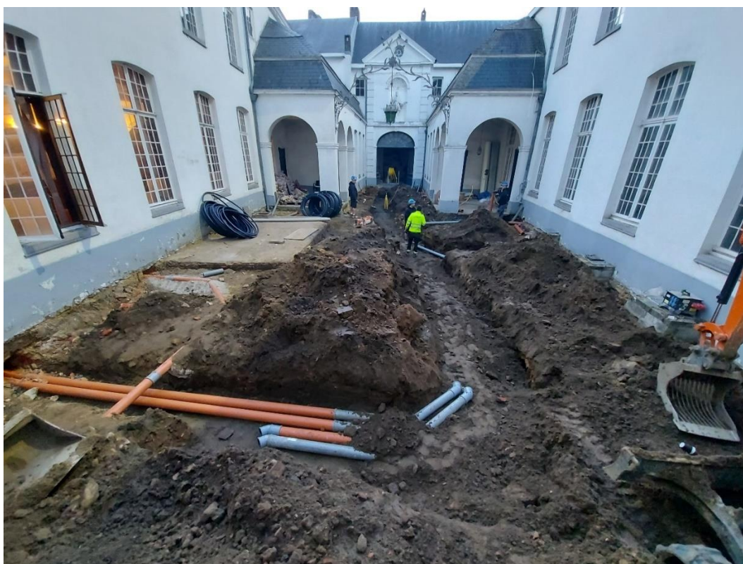
Figuur 95: zicht op de uitgegraven sleuf op de binnenkoer in functie van de rioleringsaanleg (vlak 3). Hierbij werden geen archeologische sporen aangetroffen met uitzondering van het verdere verloop van S99 en S100.
