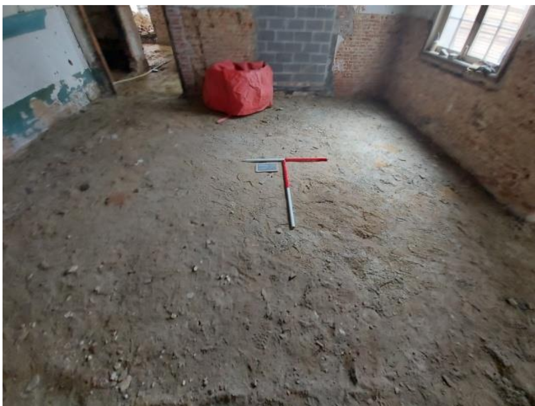
Figuur 63: Zicht op werkput 7 na het verwijderen van de bestaande vloer.
