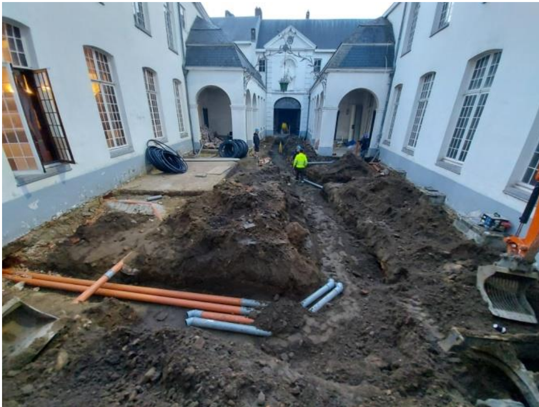
Figuur 18: Zicht op de rioleringsleuf ter hoogte van de binnenkoer.
