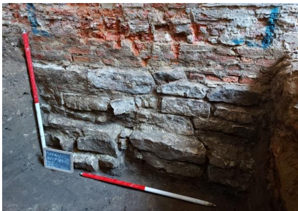
Figuur 54: Zicht op profiel 35 natuursteenfundering S104 met daarbovenop de 20 ste eeuwse binnenmuur.
