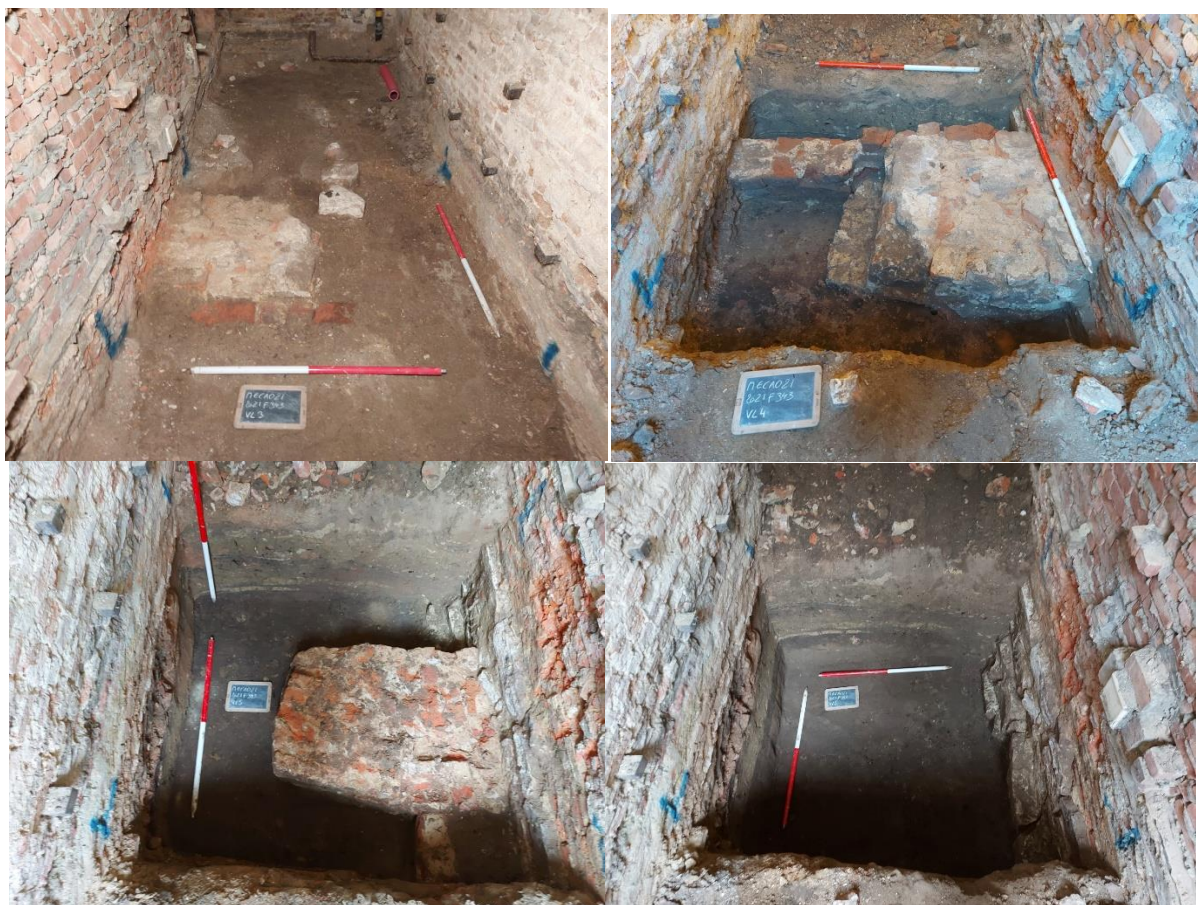
Figuur 53: Zicht op het verdiepen van de liftput ter hoogte van het massief metselwerk in werkput 5. Let op de aanbouw van dit metselwerk tegen de natuursteenfundering, die even diep werd uitgebouwd als de natuursteenfundering. Mogelijk behoren deze elementen toe aan eenzelfde bouwfase.
