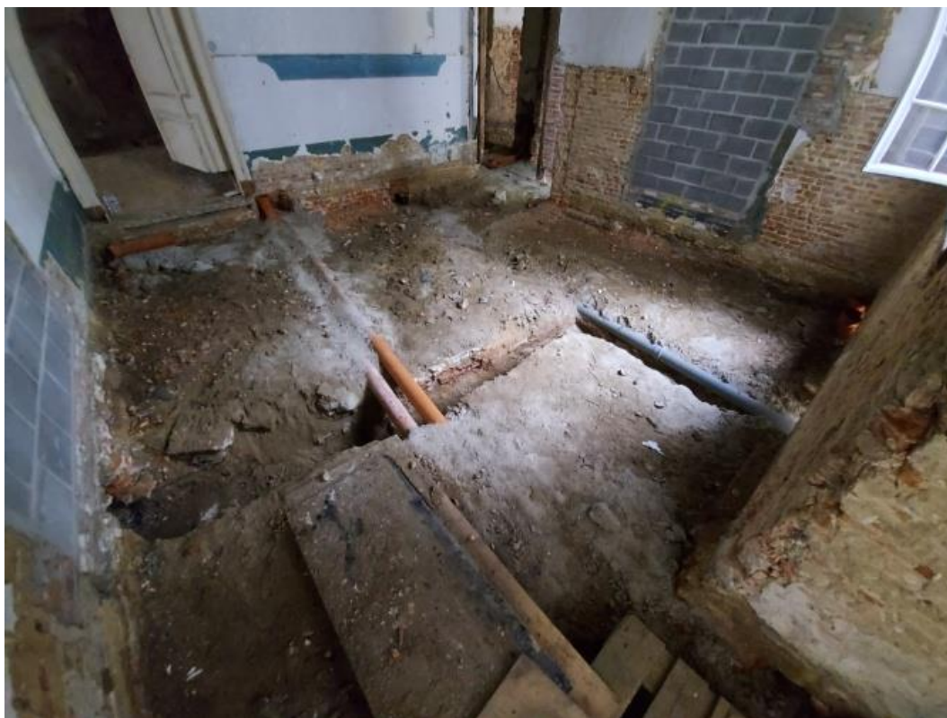
Figuur 65: Zicht op werkput 7 na de aanleg van de riolering (vlak 3). Er konden geen bijkomende archeologische resten waargenomen worden.
