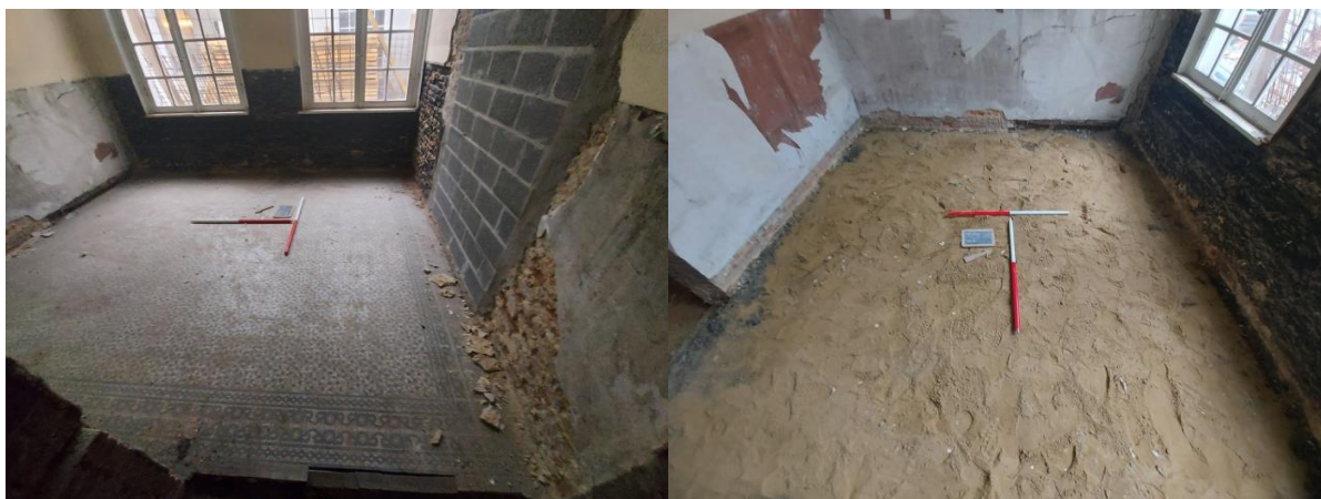
Figuur 68: Zicht op werkput 8 voor en na het verwijderen van de bestaande vloer.
