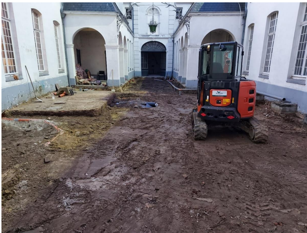
Figuur 90: zicht op de afgegraven binnenkoer in functie van de heraanleg van de verharding (vlak 2).
