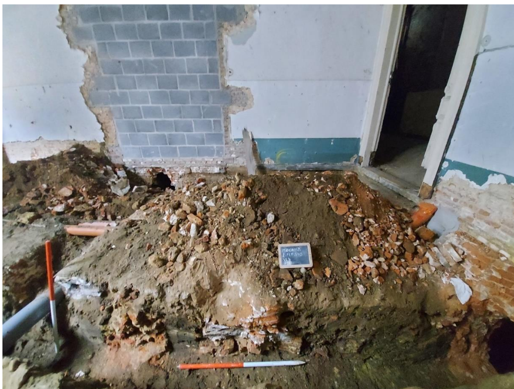
Figuur 66: Zicht op werkput 7 profiel P31 aangelegd ter hoogte van de rioleringsleuf waarbij duidelijk het ophogingspakket zichtbaar is.
