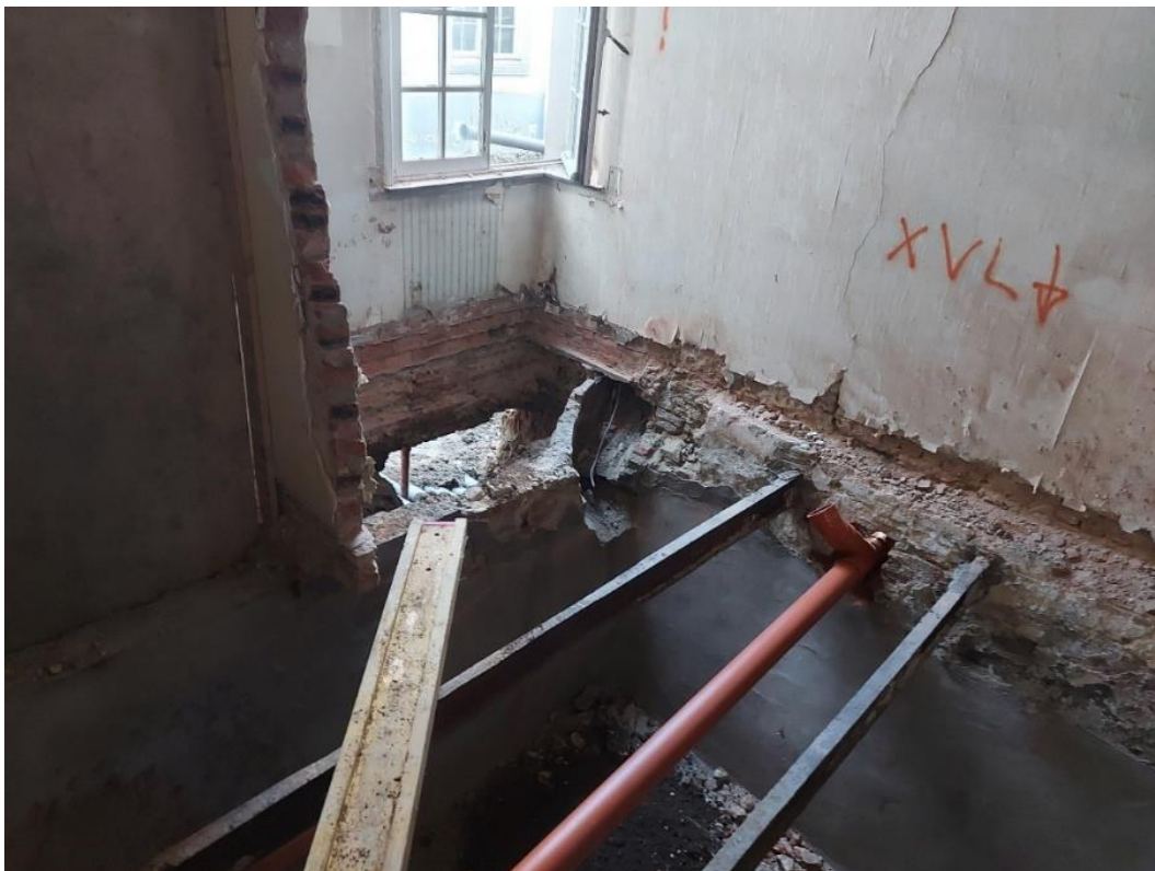
Figuur 47: Zicht op keldergewelf S46 na het opbraak.
