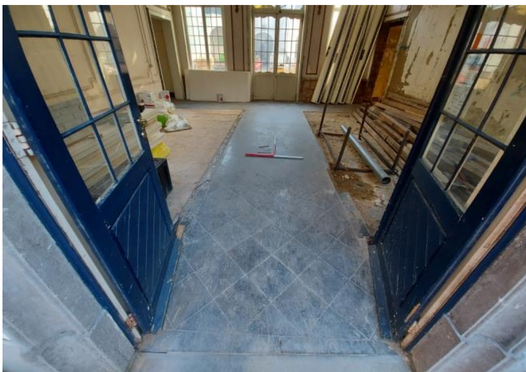
Figuur 35: Zicht op de natuurstenen vloer in de centrale hal ( vlak 1). De zijruimtes waren voorzien van een verhoogde houten vloer die bij de aanvang van het onderzoek reeds verwijderd waren.
