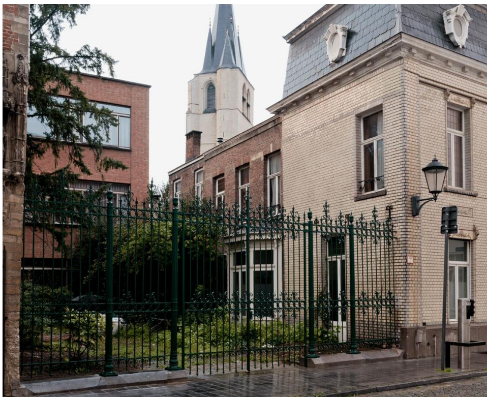
Figuur 6 Zicht op de toren van de Sint-Janskerk en het gebouw ter hoogte van de Frederik de Merodestraat 37, vanuit het zuiden (fotograaf: Michiel De Cleene 2017).
