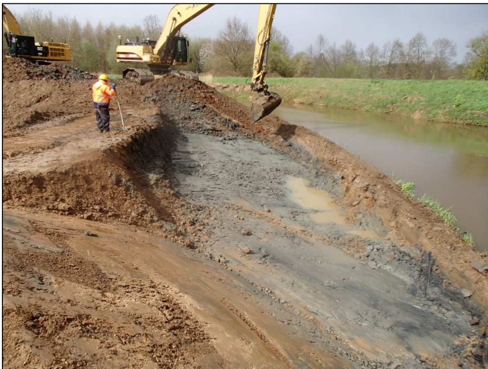
Figuur 7: Het gefaseerd uitgraven van de oostelijke meander. De zijde langs de huidige Demer is reeds op de juiste diepte uitgegraven met uitzondering van een kleine dam. Aan de zuidzijde (linkerzijde van de foto) is nog een talud aanwezig zodat de graafmachines nog weg kunnen.
