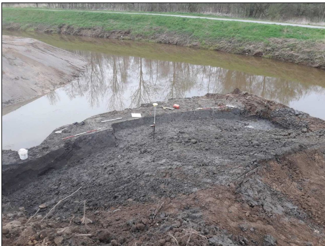
Figuur 11: Werkfoto met daarop het volledige profiel in WP1. Ter hoogte van het profiel is reeds de uit te graven diepte bereikt.
