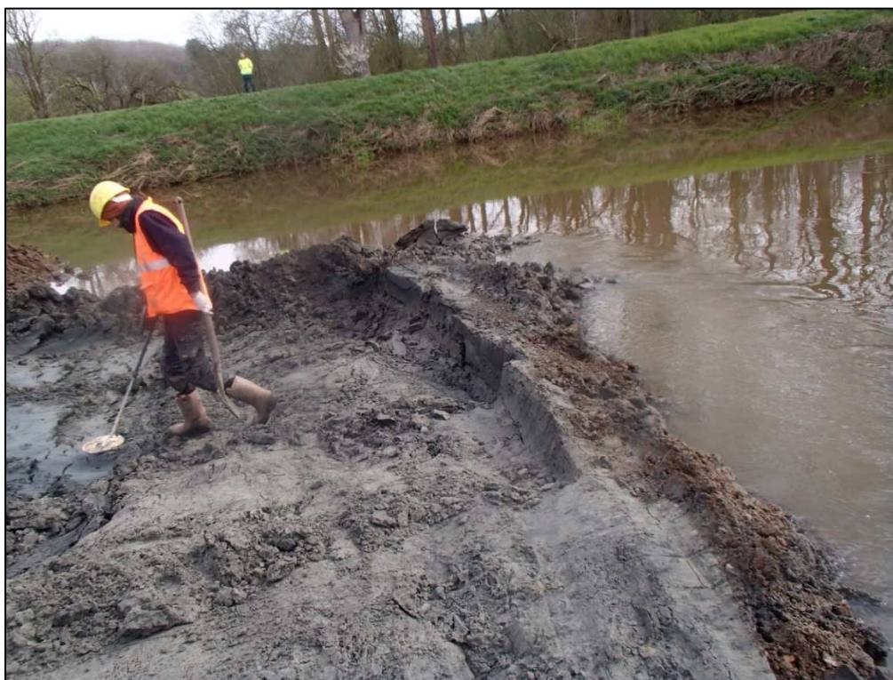
Figuur 8: Het uitgraven van het laatste deel. De meander staat nu weer in verbinding met de Demer. Een kleine dam voorkomt het instromen van water.
