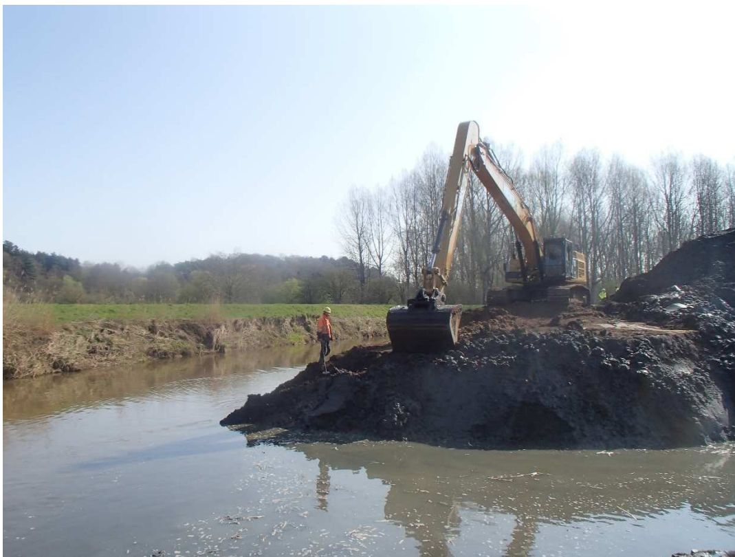
Figuur 5: Opstelling van de graafmachine aan de binnenkant van de historische meander.
