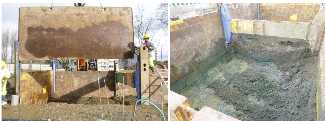
Figuur 44: Aanbrengen van beschoeiing en uitgraven van zone voorzien voor technische ruimte en waterreservoir (Abo nv, 2018)
