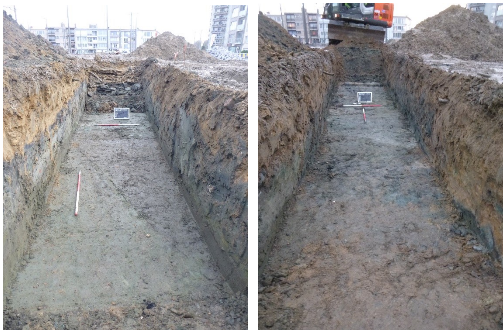
Figuur 26: Zicht op begin en einde van gracht (S1.1) (Abo, 2018)
