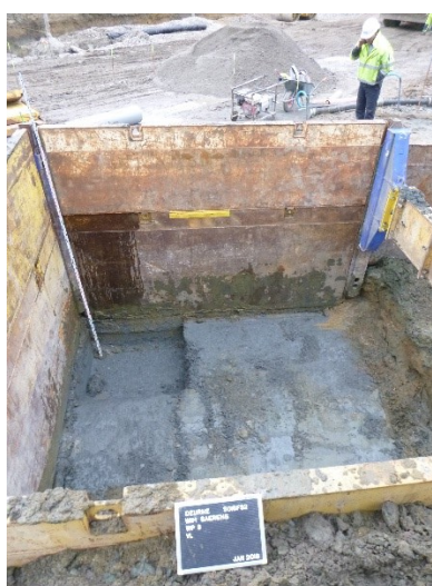
Figuur 45: Vlak op niveau van diepste uitgraving (Abo nv, 2018)
