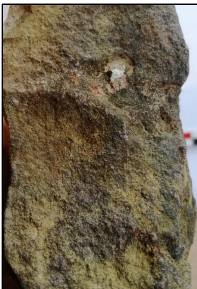
Figuur 79 Detail van de granulaire structuur van de veldstenen gebruikt als fundering van de hoevemuur S38.
