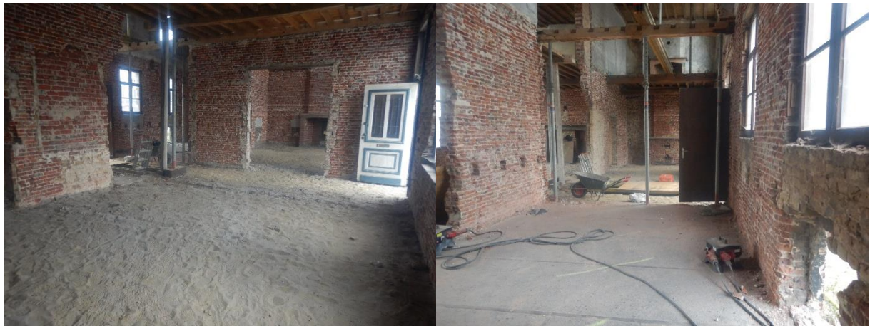
Figuur 9: Zicht op de overige binnenruimtes op het gelijkvloers.
