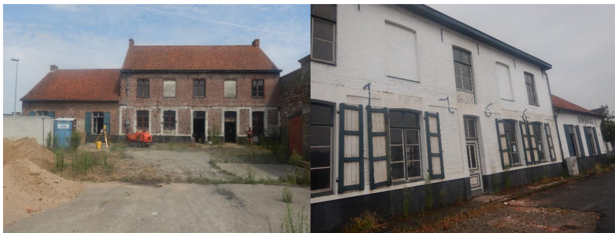
Figuur 7: Zicht op de achterzijde (links) en vooraanzicht van de beide gebouwen (rechts).
