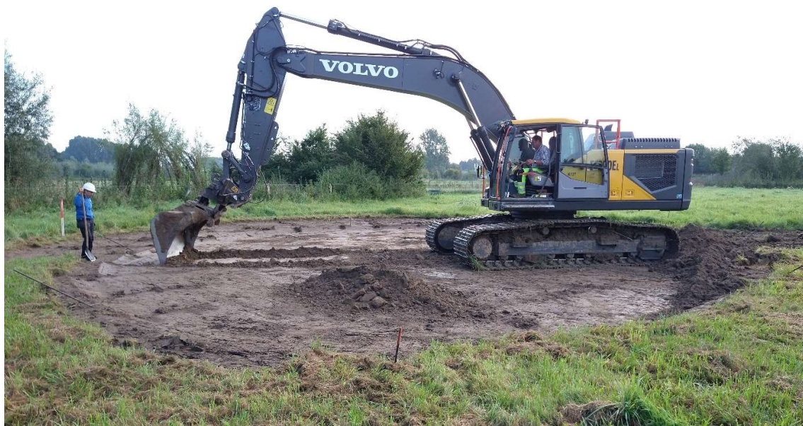
Figuur 7. Uitvoering van het onderzoek tijdens het uitgraven van de poel (zone E).
