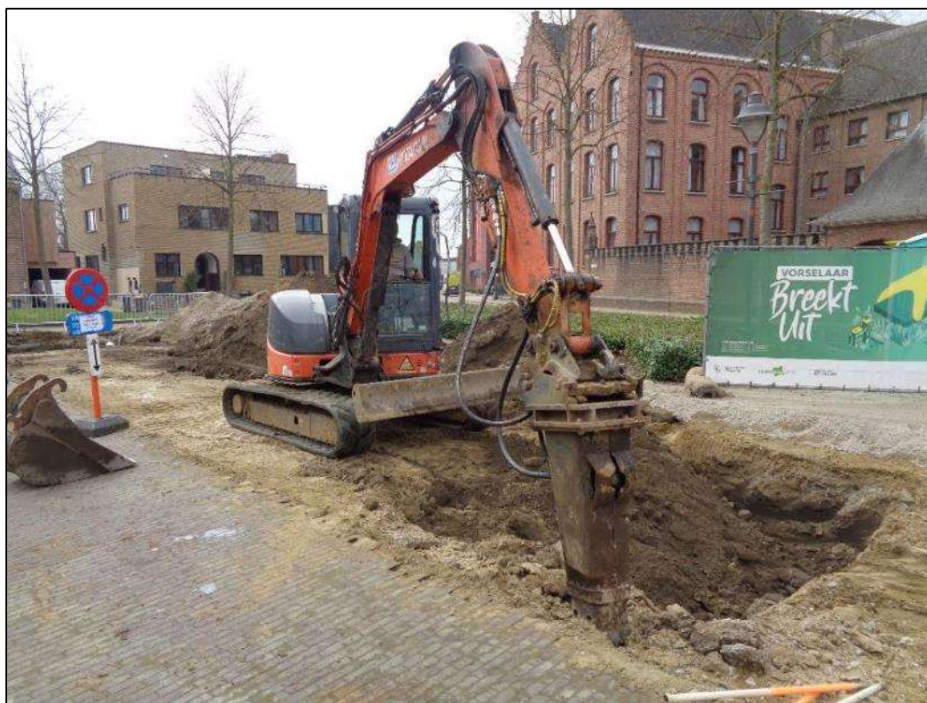
Figuur 3: Materiaal aangewend om door de fundering van de verharding en ophogingslagen te raken
