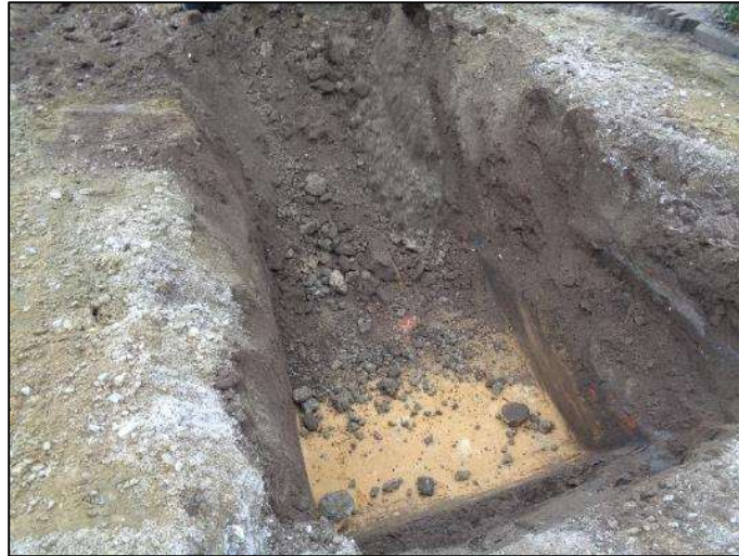
Figuur 13: Zicht op het aanleggen van werkput 3
