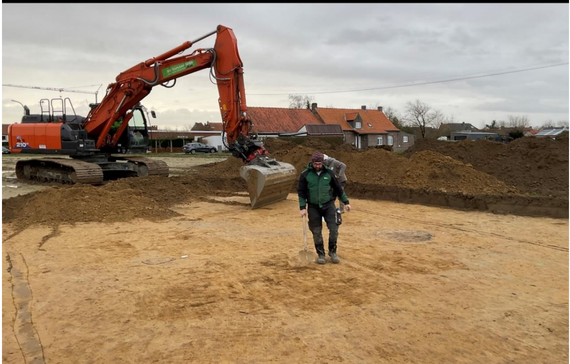
Figuur 8: fotografische opname van de aanleg van een werkput met zicht op aanwezige drainages en sporen.
