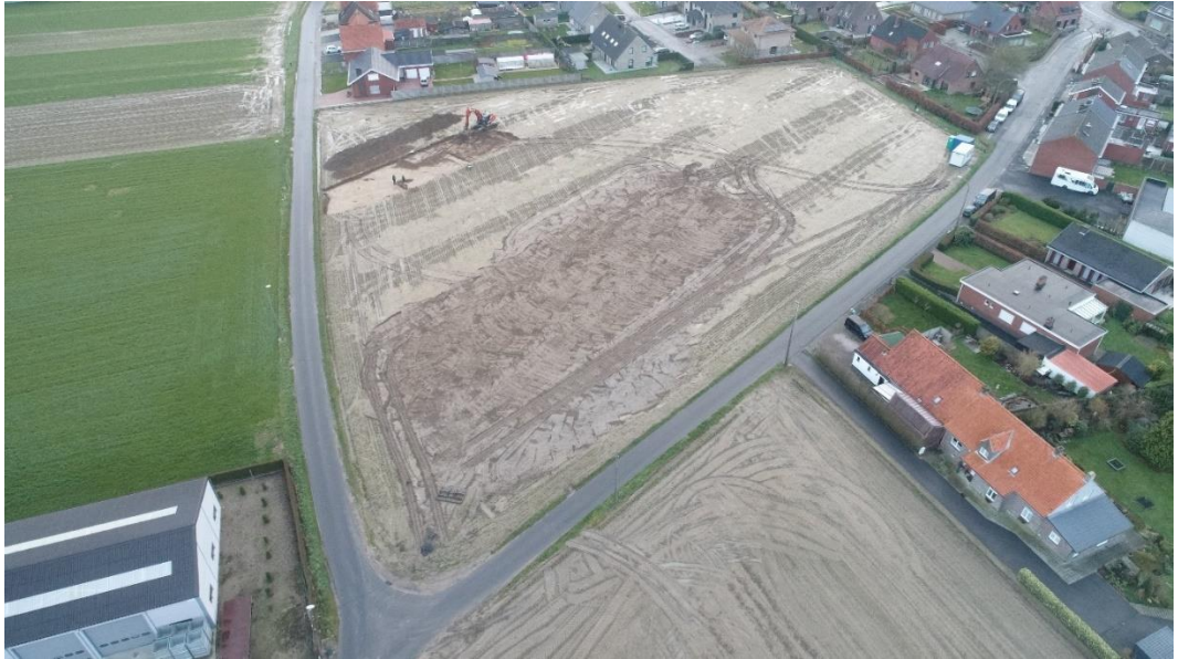
Figuur 45: fotografische opname van de aanleg van werkput 2.
