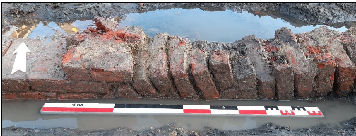
Figuur 19: Aanzet van een spaarboog in muur S1108
