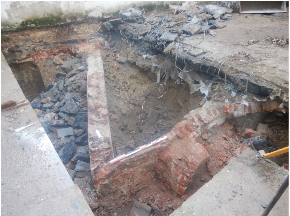
Fig. 22: Muur S11 (onder de noordpijl) na afbraak van het gewelf en bovenliggende betonplaat. Onder de maatbalk situeert zich S32.
