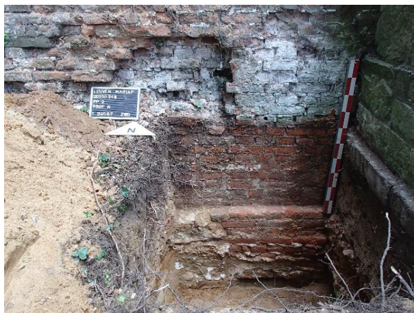
Figuur 24. Profielput PP2, zicht op noordmuur, ten westen van Statie VI (rechts op foto).
