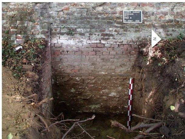
Figuur 25. Profielput PP3, zicht op westmuur, grenzend aan steunbeer.
