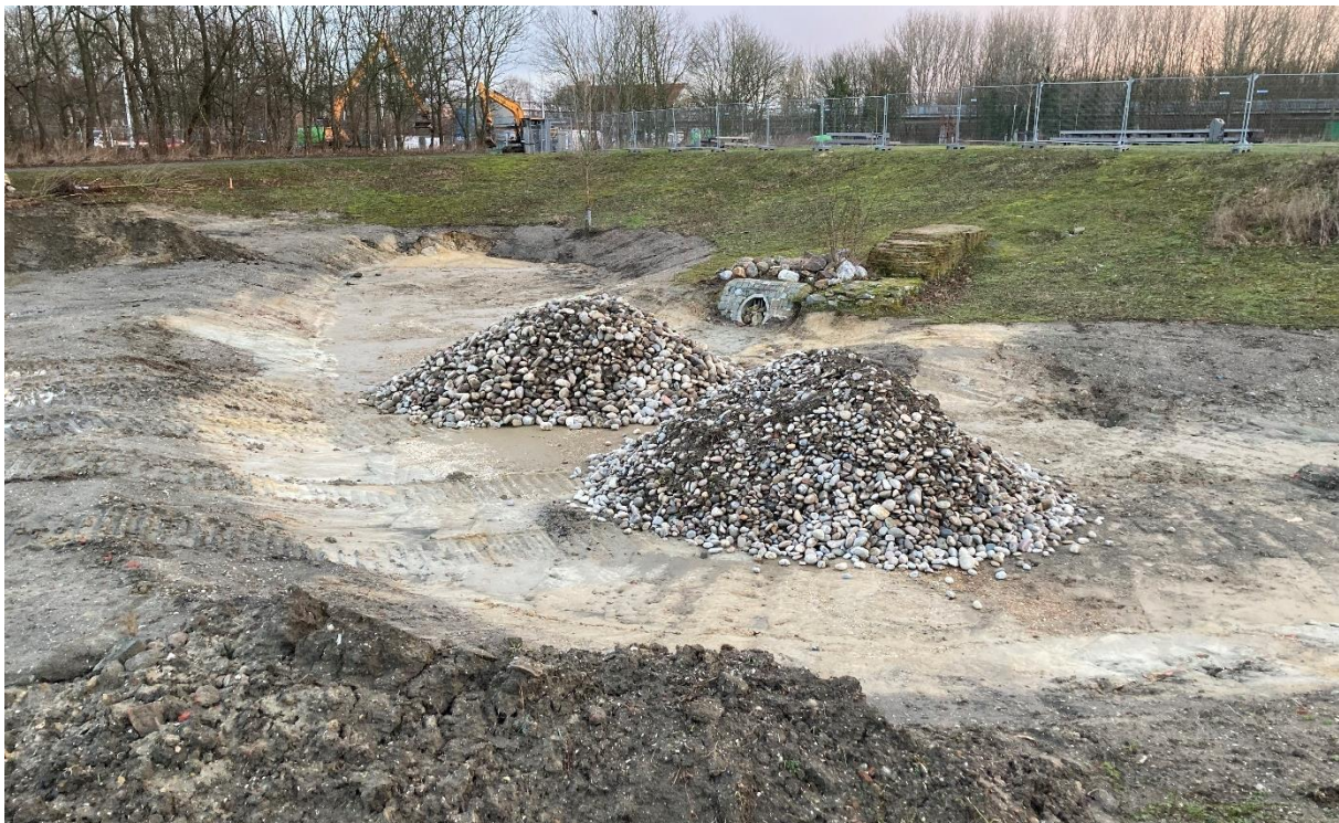
Figuur 16: zicht op de algemene uitgravingen in de centrale zone van het onderzoeksgebied
