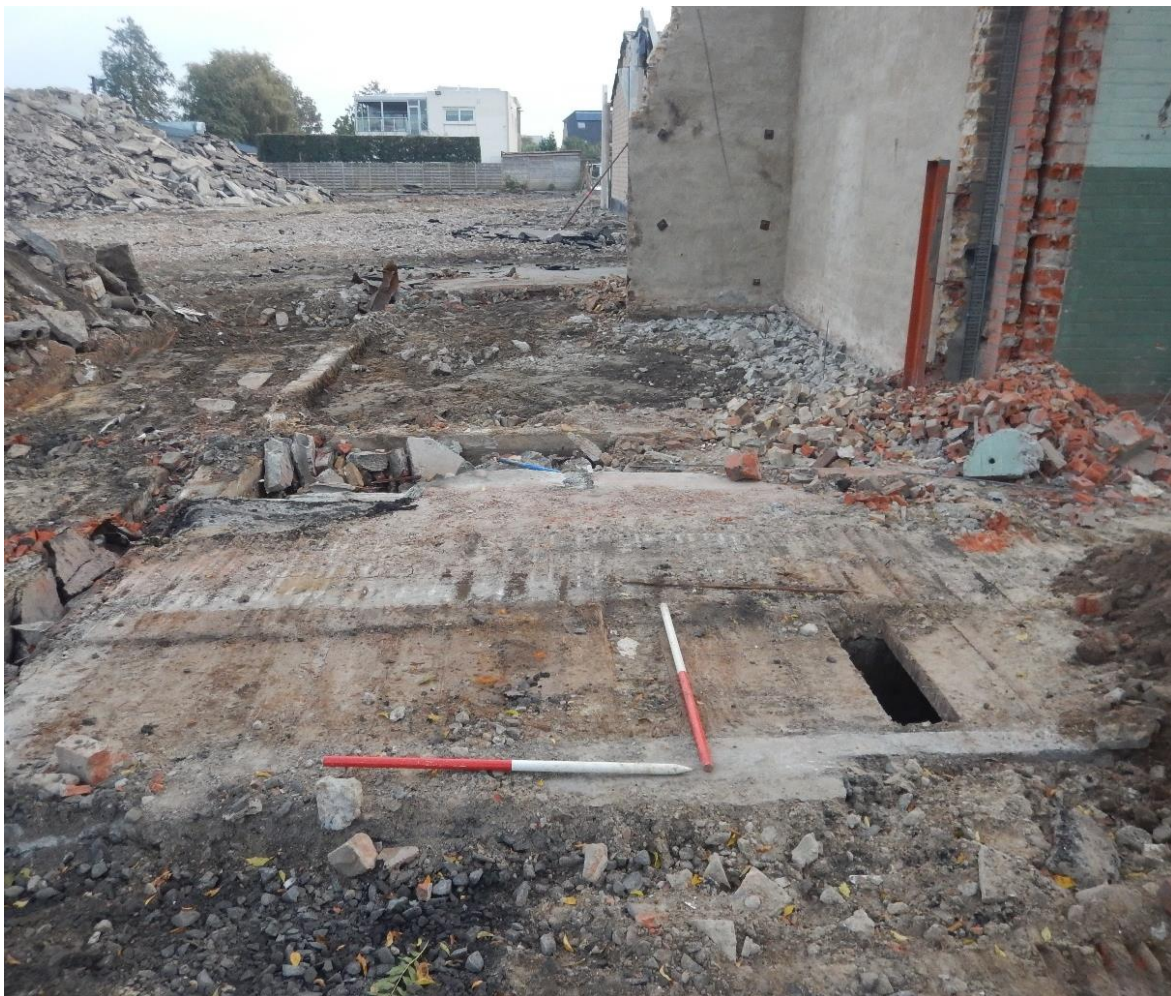
Figuur 6: Zicht op de recente fundering en afvalwatercollector.
