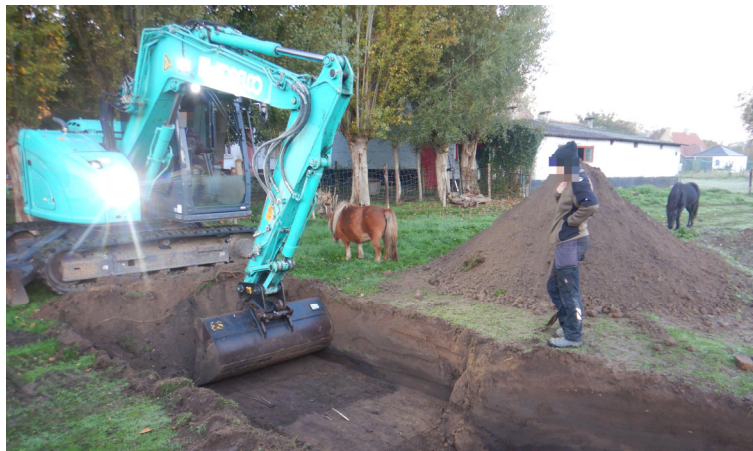
Figuur 4. Inzet van verschillende graafmachines voor het onderzoek op beperkte oppervlakte.
