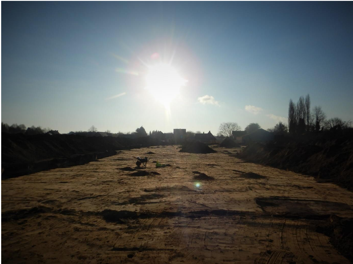
Figuur 12: Sferbeeld tijdens de werkzaamheden.
