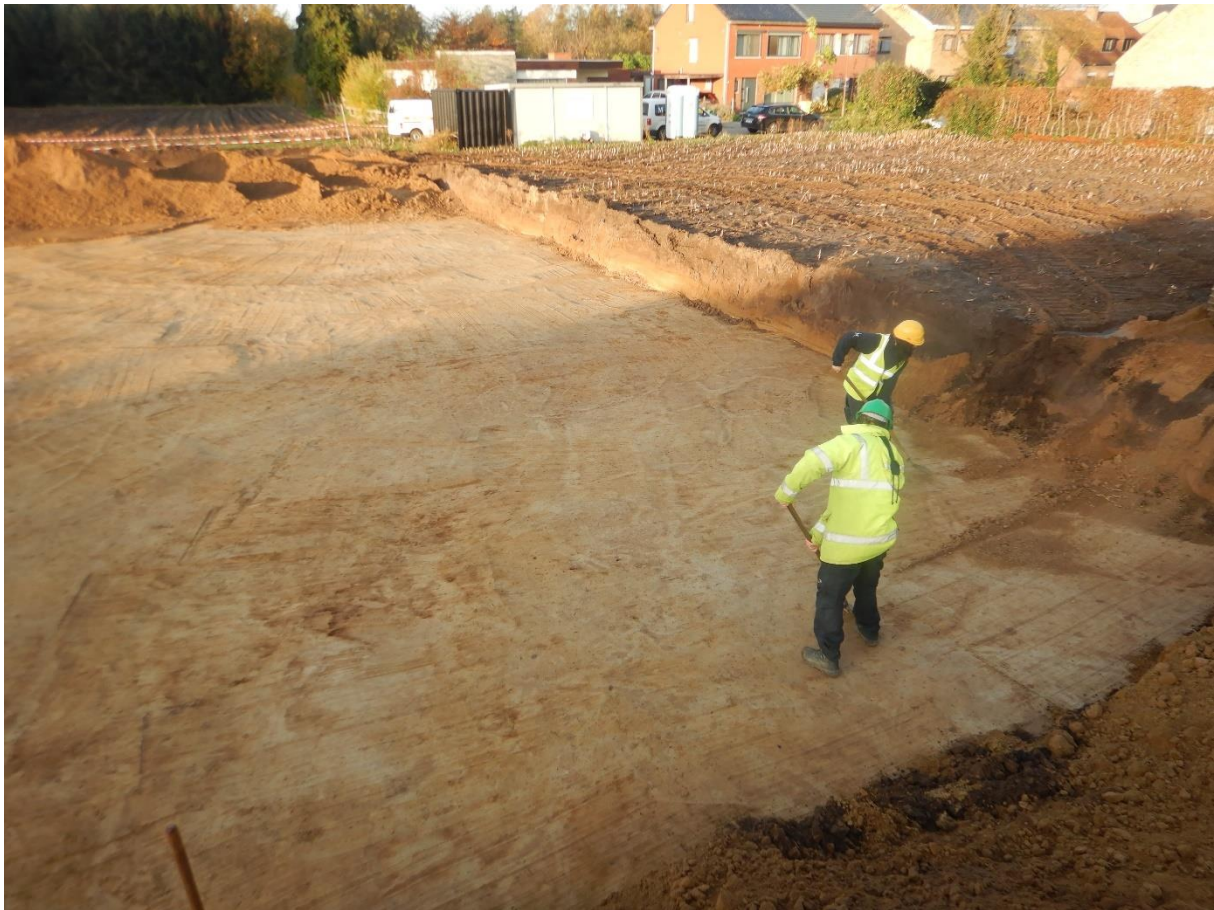
Figuur 30: De werkzaamheden in het noorden van werkput 5.
