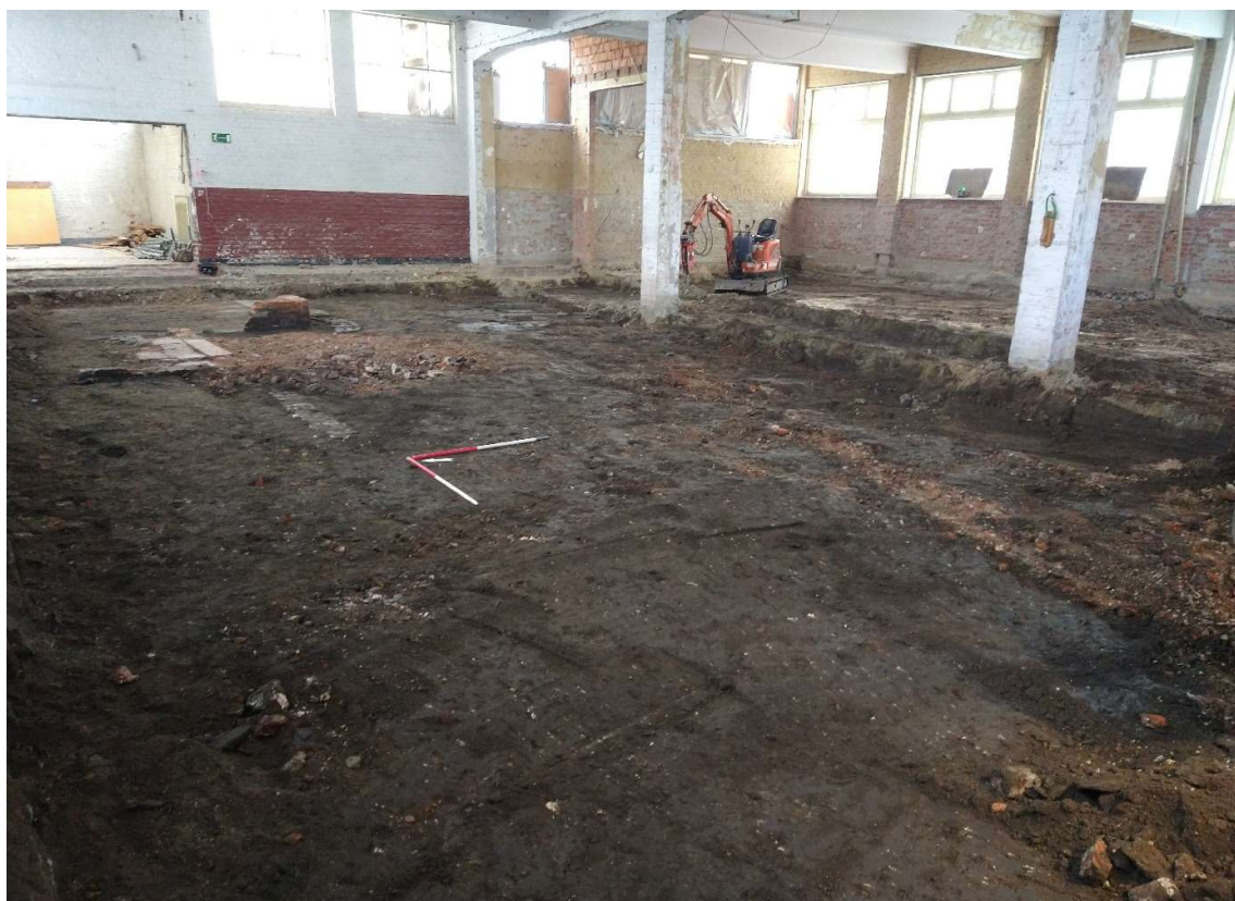
Figuur 21. Noordelijke zone van het turngebouw na het afgraven.
