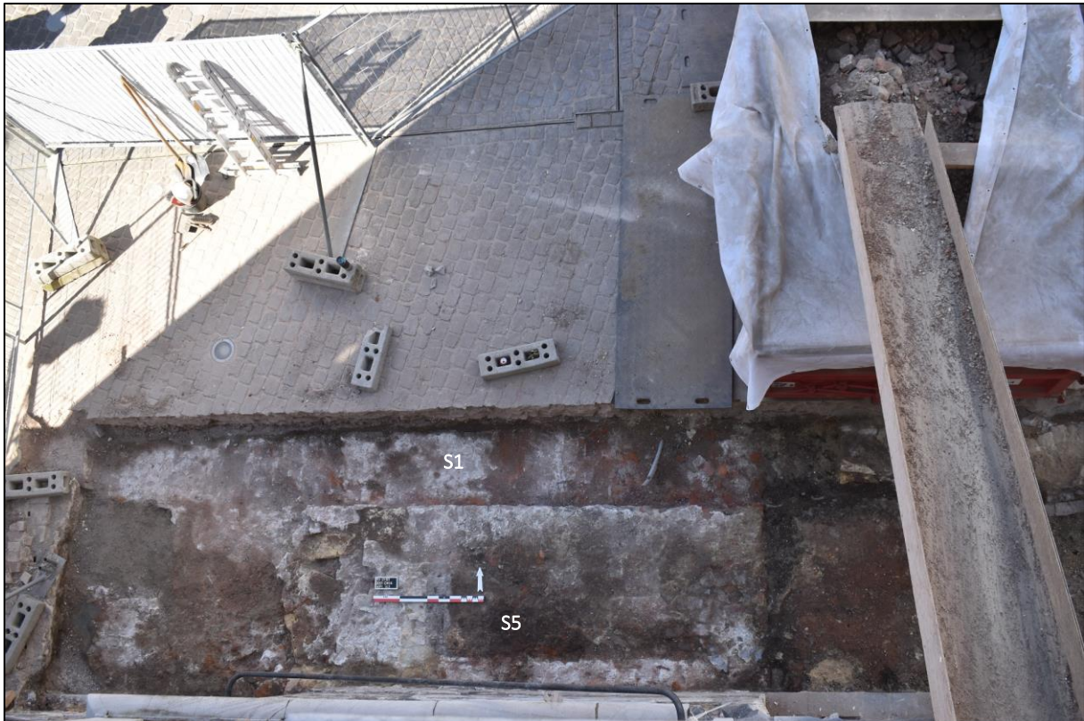
Afb. 32: Zone 1 (westelijke helft), ter hoogte van de façade van het stadhuis en de afgebroken trap.
