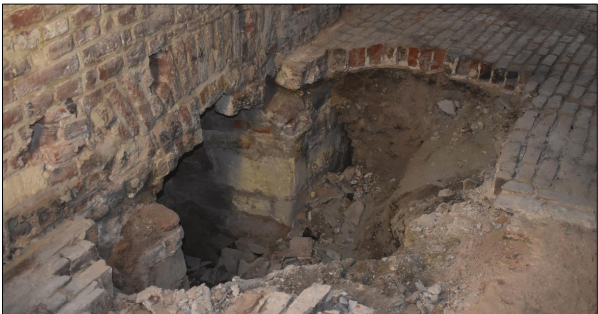
Afb. 39: Zone 3: voormalige kelder en keldergat, opgevuld met puin.
