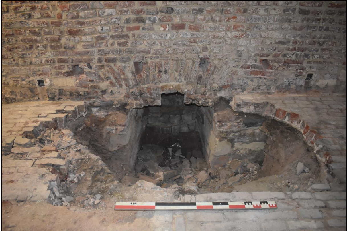
Afb. 38: Zone 3: doorgang voor nutsleidingen doorheen de gelijkvloers en opgevulde oude kelderruimte.
