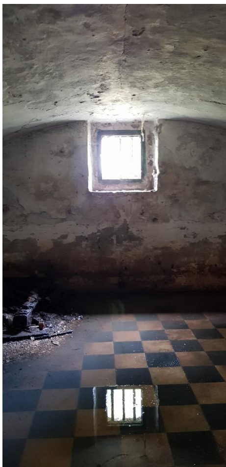
Figuur 19: Foto's van zuidelijk kelderdeel (boven) en noordelijk kelderdeel (onder) van het woongebouw
