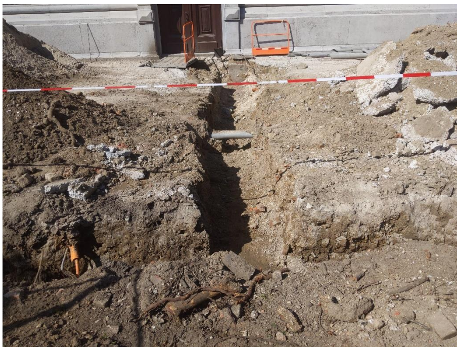
Figuur 7: Graafwerken op 30 maart; dwarssleuven aan de achterzijde van het gebouw
