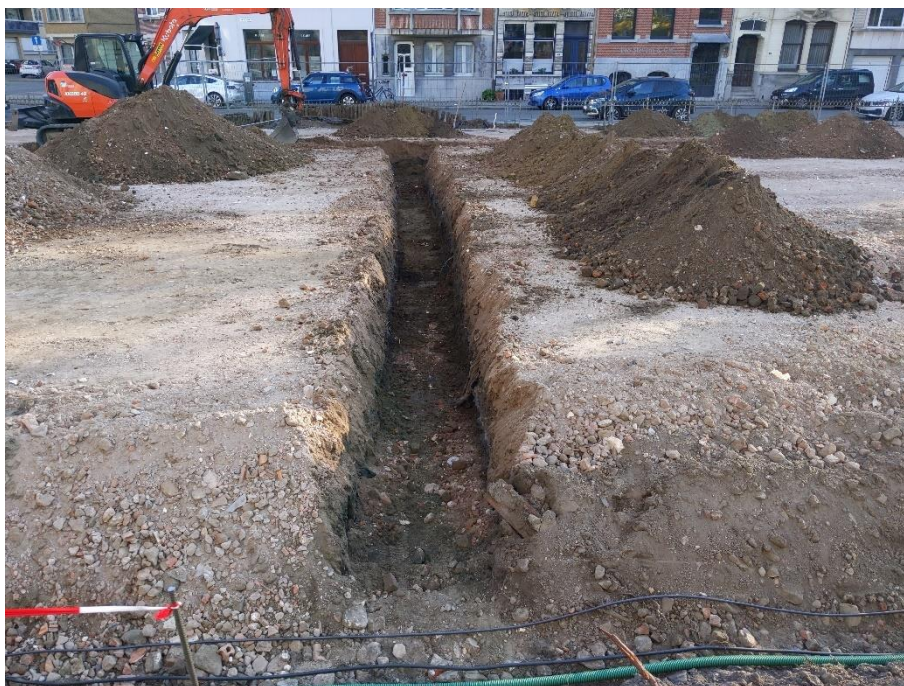
Figuur 8: Graafwerken op 31 maart, een dwarssleuf aan de zuidzijde van het gebouw
