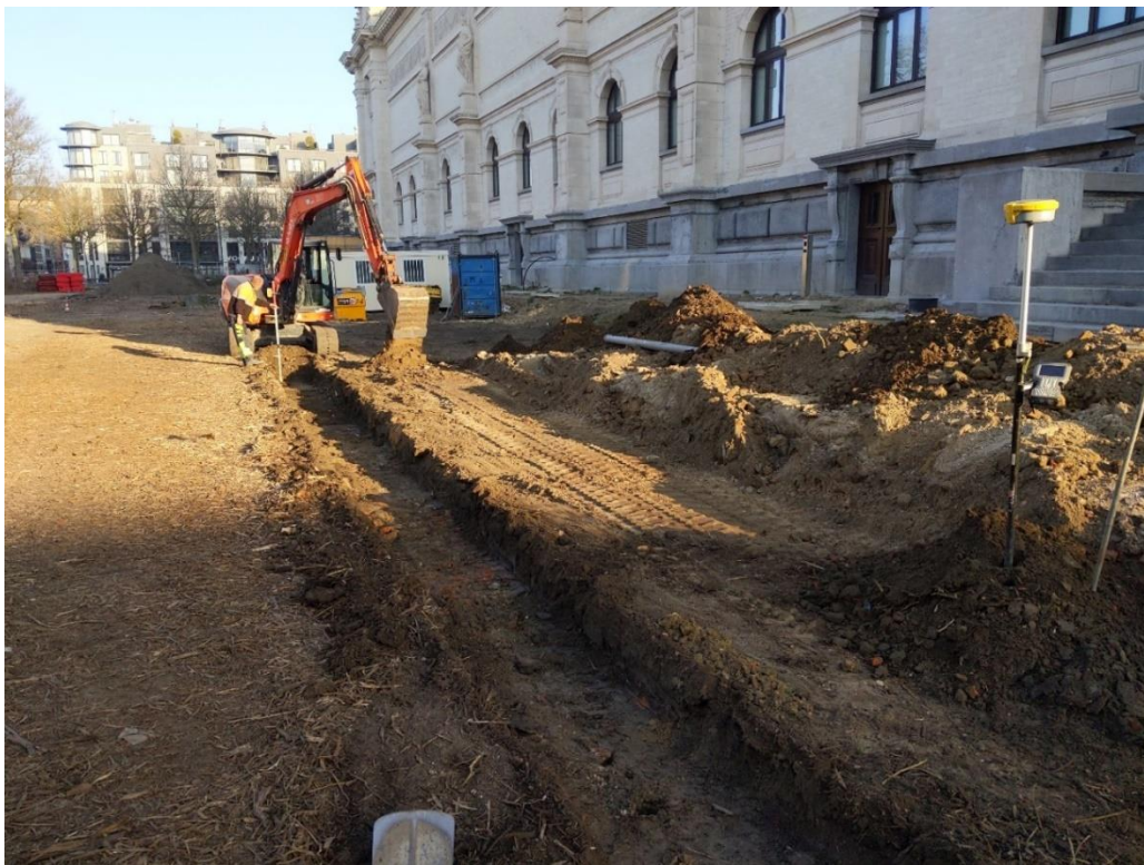
Figuur 3: Werkwijze uitgraving. Niveau werd steeds gecontroleerd d.m.v. lazer.
