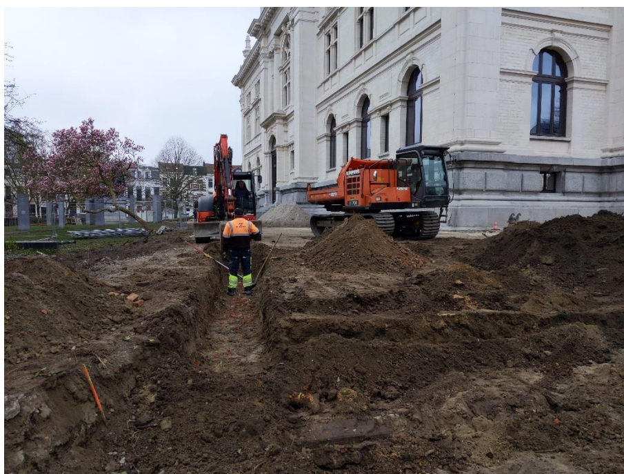
Figuur 5: Graafwerken op 25 maart, ter hoogte van de noordoostelijk hoek van het museum
