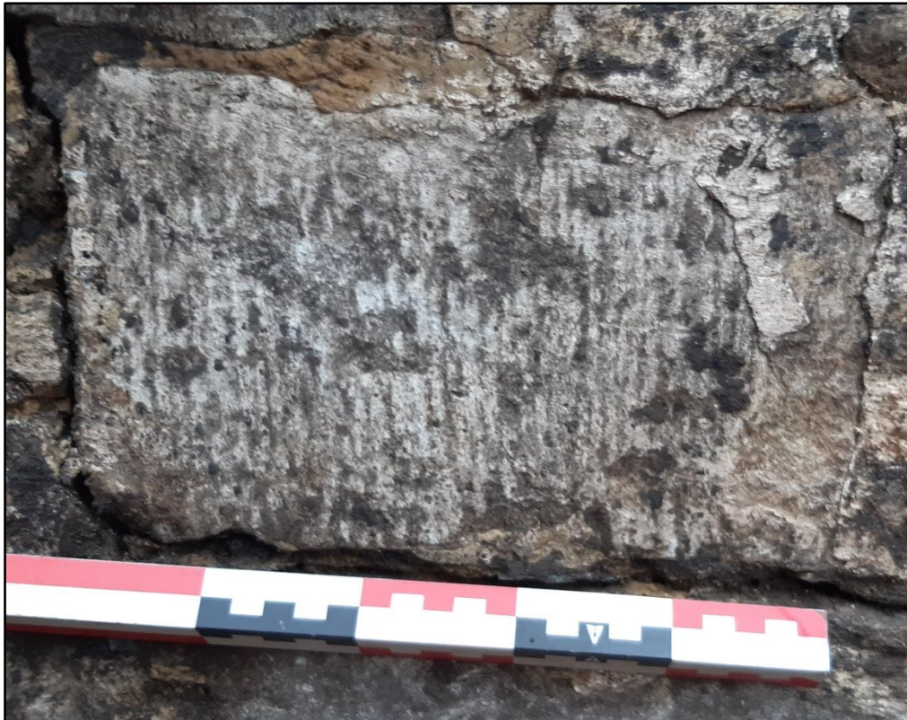
Figuur 43: Natuursteen met onregelmatig verticale frijnslag (ABO nv 2021)
