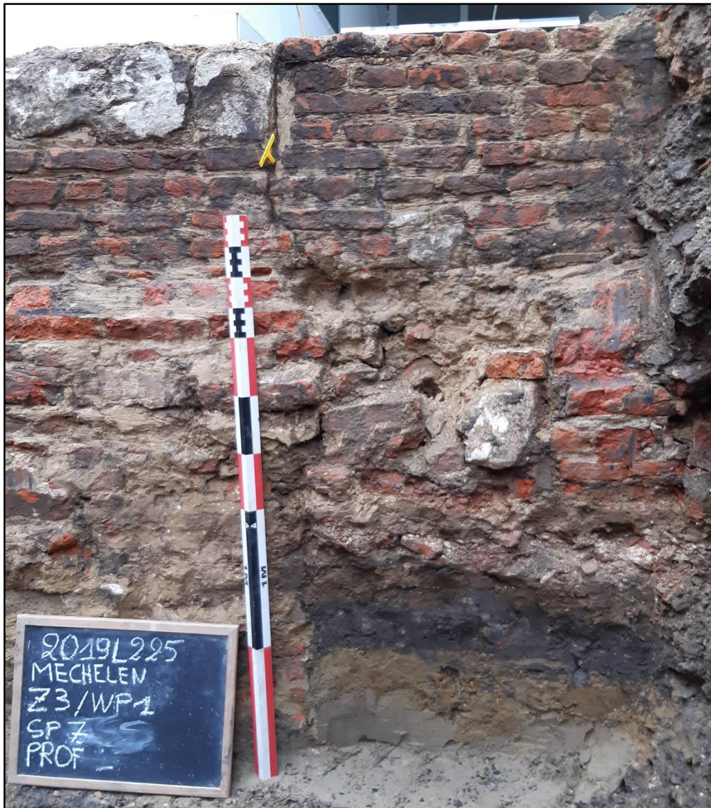
Figuur 47: Verticale bouwnaad in muur spoor 1 (ABO nv 2021)
