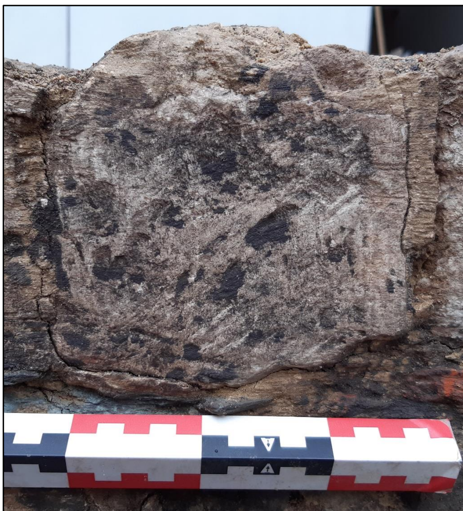
Figuur 45: Natuursteen met onregelmatig schuinstaande frijnslag (ABO nv 2021)
