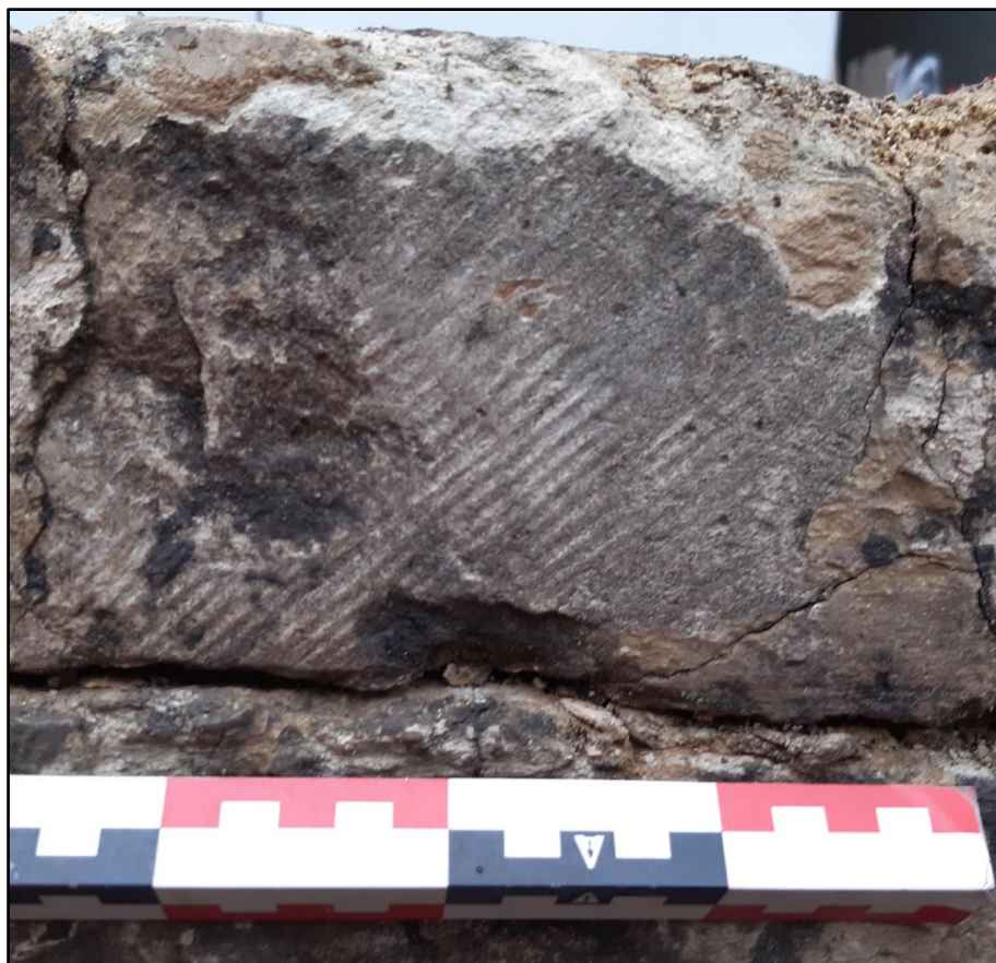
Figuur 44: Natuursteen met regelmatige schuinstaande frijnslag (ABO nv 2021)
