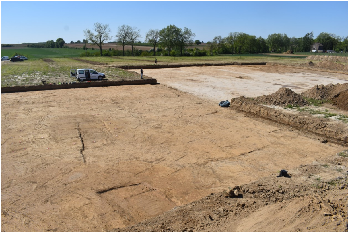
Afb. 19: Zicht op WP1 (achter) en WP2 (voor). Foto genomen vanuit het zuidoosten (Bron: Aron bv, digitaal, dd.25/05/2020).
