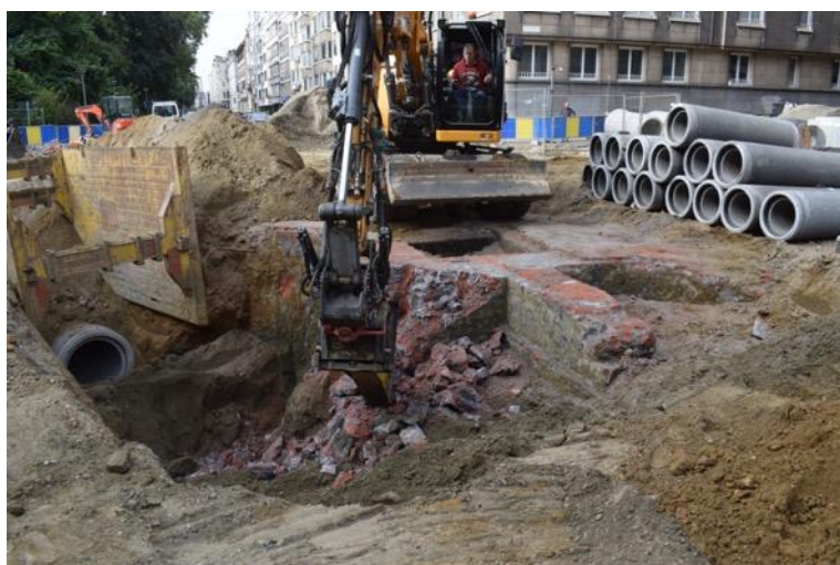
Figuur 6: De afbraak van de bakstenen fundering in functie van de geplande werken (© dienst archeologie, stad Antwerpen).
