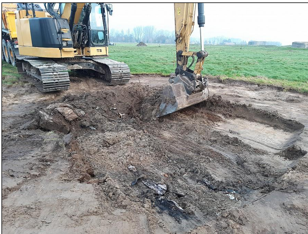
Figuur 5: Werkput 6 tijdens het ontruimen van het puin
