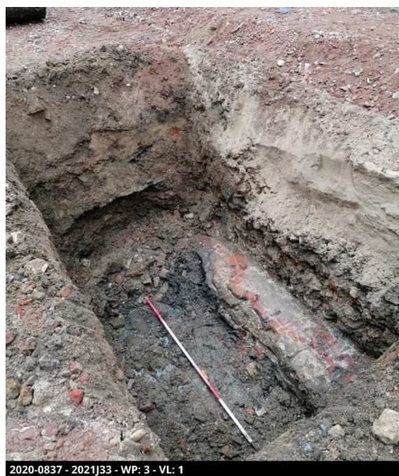
Figuur 10: Werkput 3.1 met de oude kademuur. Foto richting zuidwesten.
