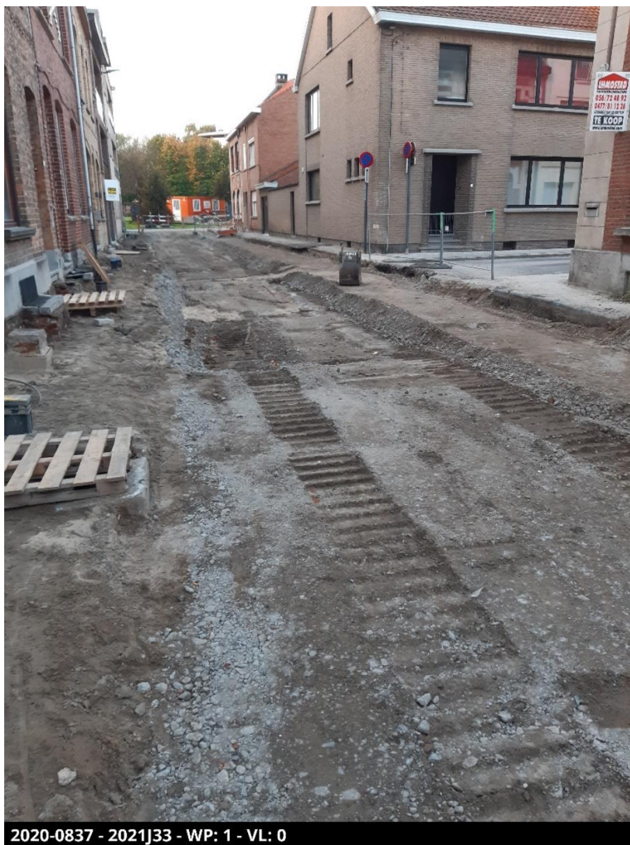
Figuur 4: Advieszone A net voor aanvang. Foto richting zuiden/Zaalhof.
