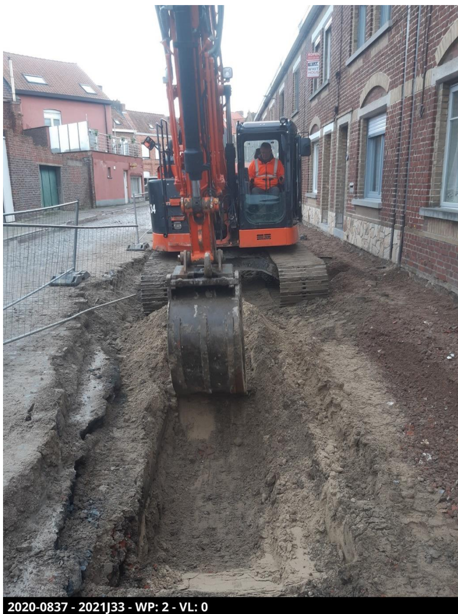
Figuur 8: Verstoring en aangebracht zand in de werkputten in Zone B.
