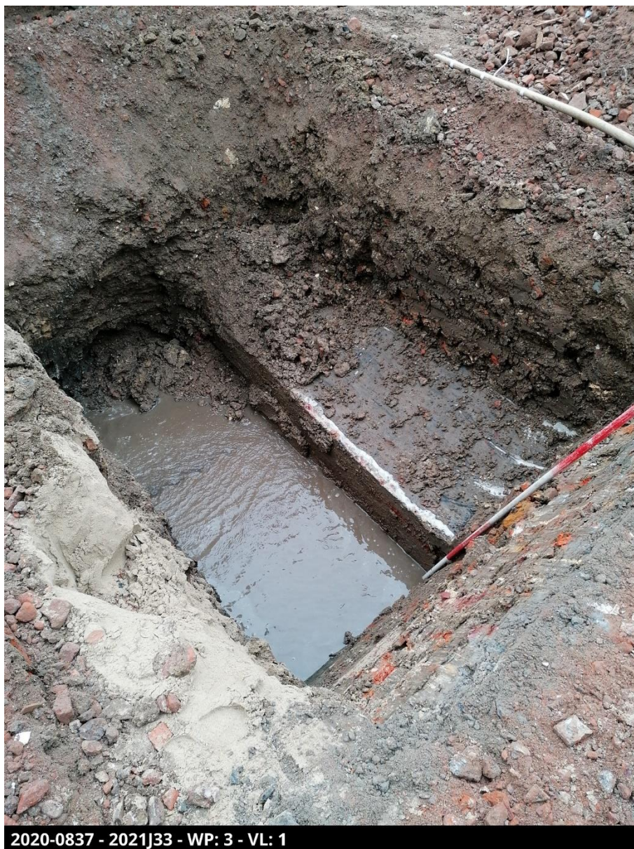
Figuur 11: Werkput 3.3 met de ingekokerde leperlee en wateroverlast.
