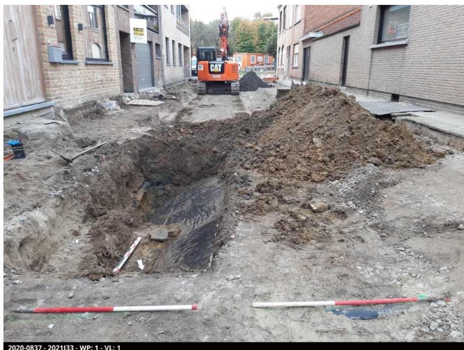
Figuur 5: Werkput in Zone A. Foto richting zuiden.
