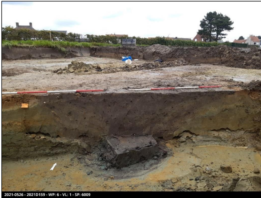
Figuur 12 : Foto van de coupe S6009 op vlak 1, zichtbaar worden van de bekisting.
