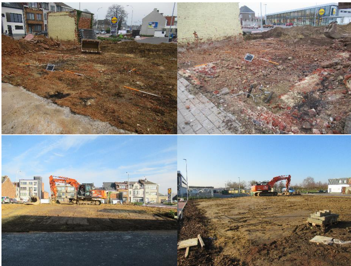
Figuur 4: Overzichtsfoto's sloopbegeleiding 2020K281.
