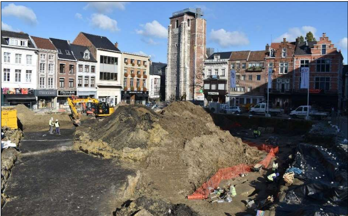
Fig. 16: De aanleg van Zone 4, VL1. Dit gebeurde tijdens het opgraven van Zone 2 (Aron bv, 29/10/2019).
