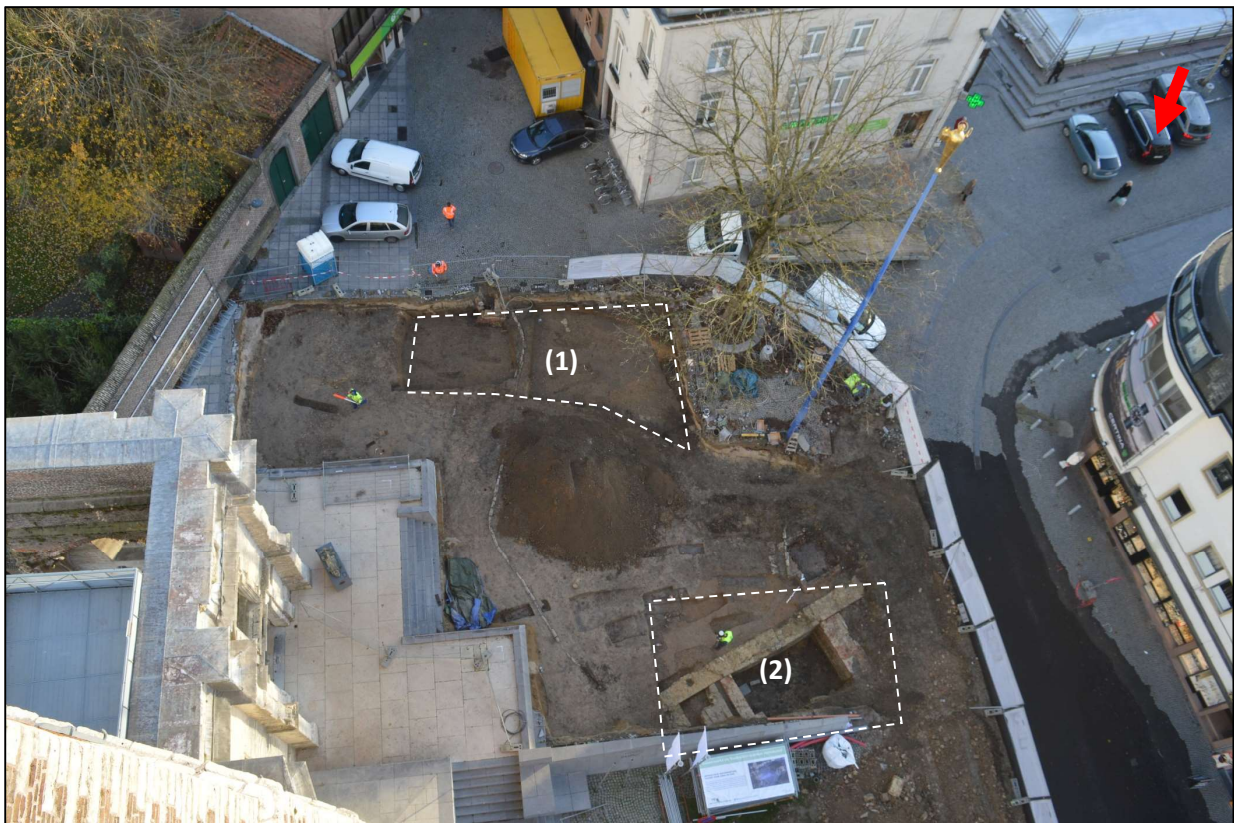
Fig. 6: WP1, VL2, met twee lokale verdiepingen ter hoogte van het toekomstig rioleringsstracé (1) en de controlekelder (2) (Aron bv, 04/12/2018).
