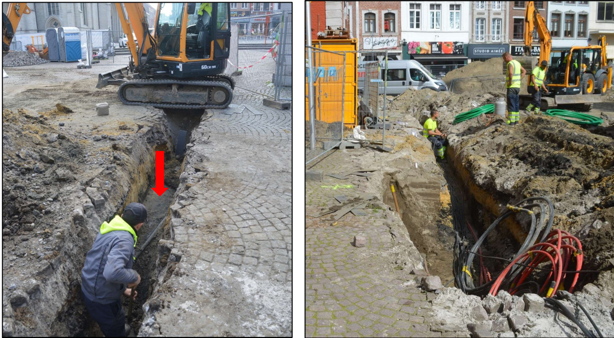
Fig. 25-26: Opname van het aansnijden van de schuilkelder (rode pijl) en het opvolgen van de nutswerken (Aron bv, 12/04/2019 en 12/08/2019).
