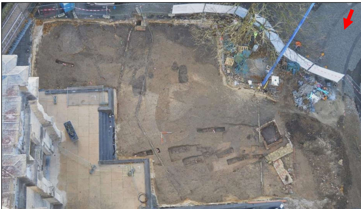
Fig. 5: WP1, VL1: het vlak ter hoogte van het Trudoplein met in het noorden (beneden op de foto) de deels vrijgelegde bebouwing en graven. In het zuiden is de aanzet van de begravingen te zien (Aron bv, 09/11/2018).
