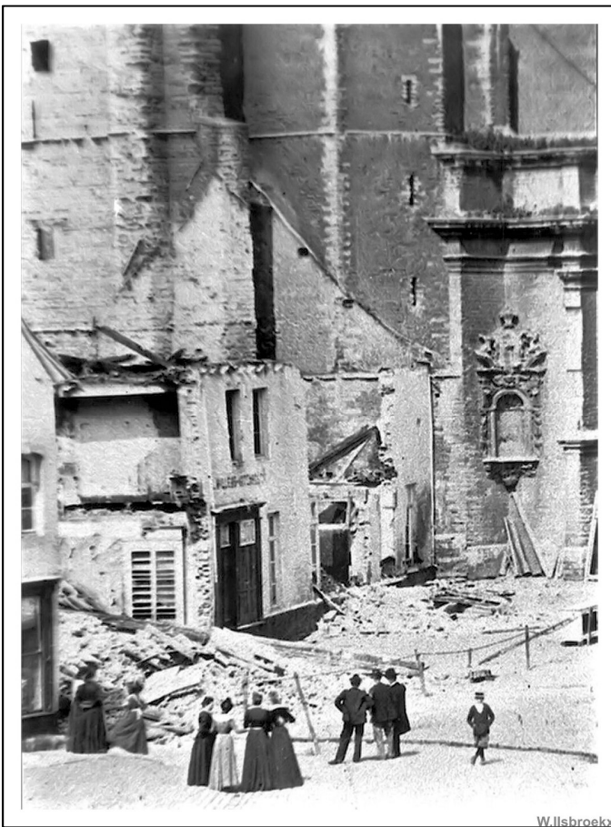
Fig. 53: De schade na de brand.
