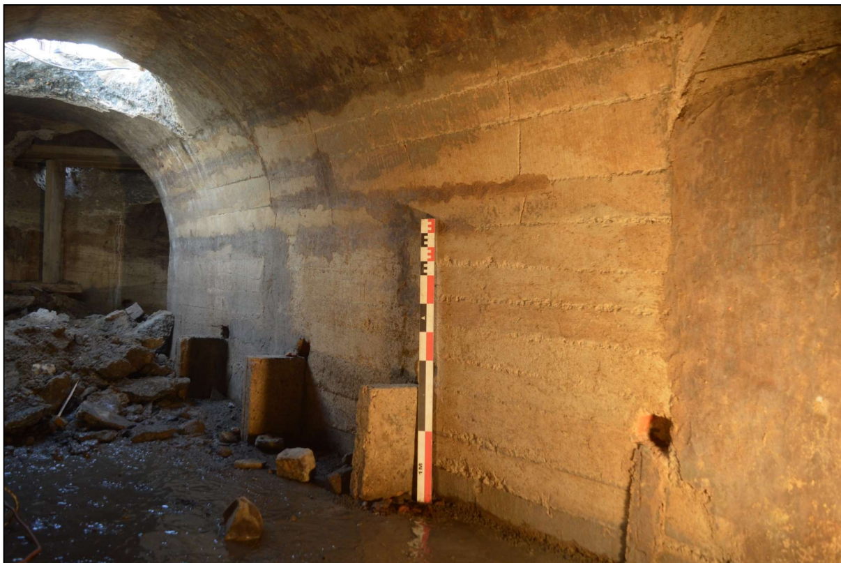
Fig. 143: Binnenin de schuilkelder: betonnen steunen langs de wanden, die vermoedelijk houten planken hebben ondersteund en zo dienst deden als zitbank (Aron bv, 22/08/2019).
