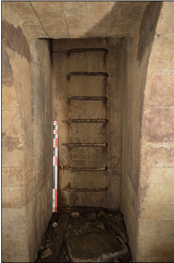
Fig. 146: Trapladder naar de uitgang. Aron bv (22/08/2019)
