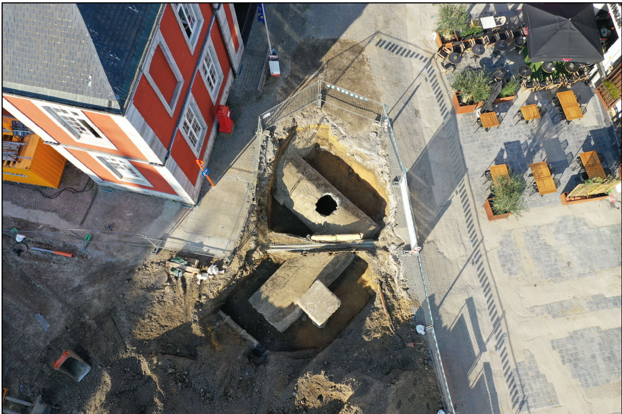
Fig. 142: bovenaanzicht van de schuilkelder (Hc Create, 05/08/2019).
