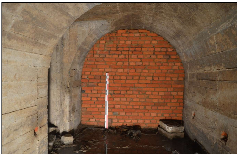
Fig. 145: Een gedeelte van de schuilkelder werd na de oorlog dichtgemetseld. Aron bv (22/08/2019)
