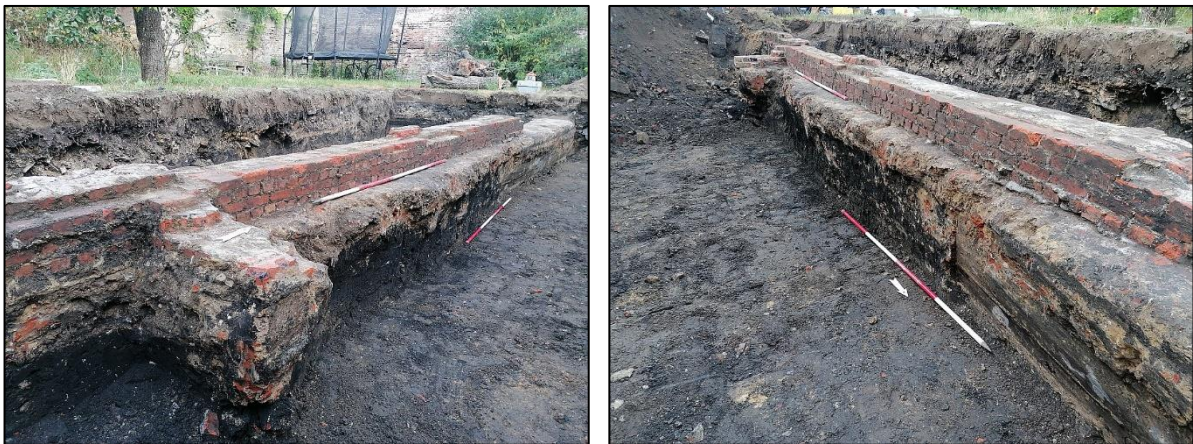
Figuur 8: Muur met fundering (S1002)
