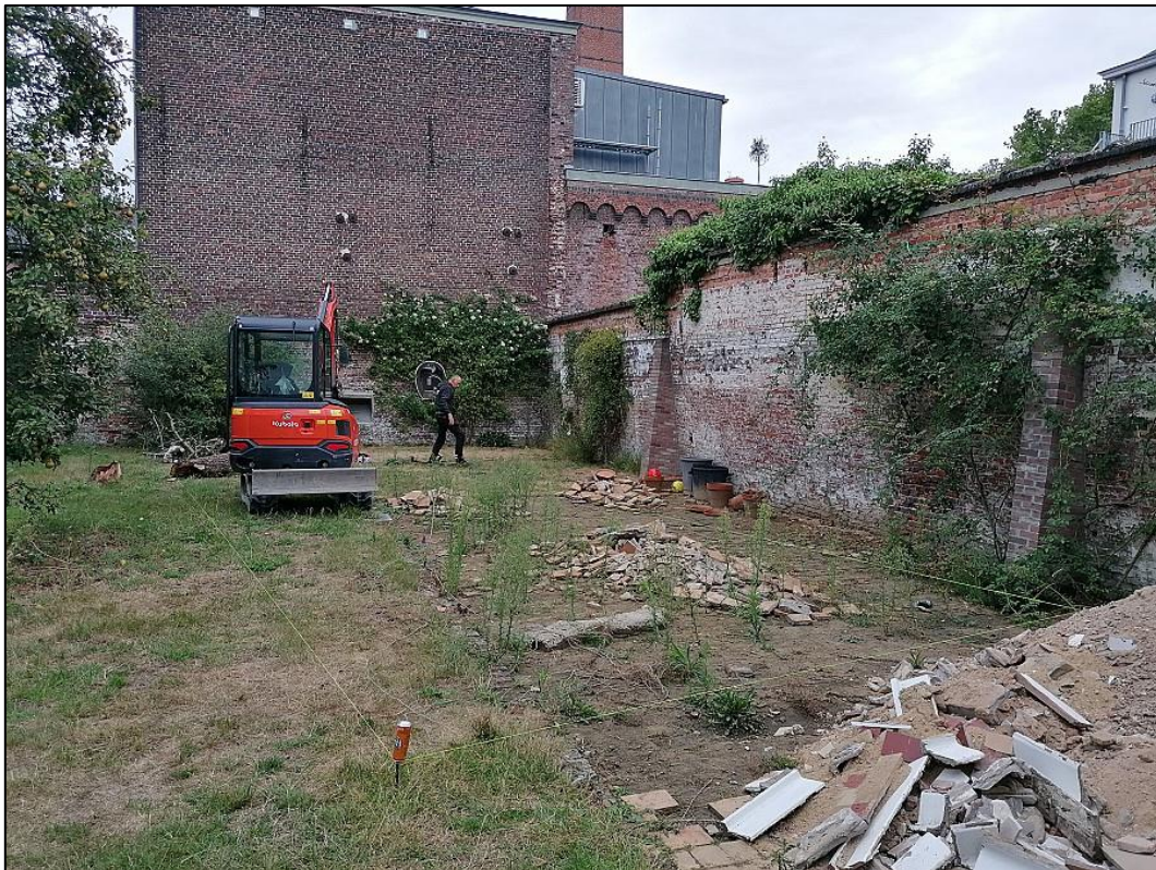
Figuur 3: Onderzoeksterrein net voor de start voor de graafwerkzaamheden
